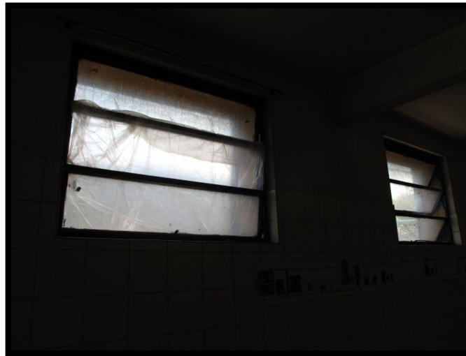
E. C. N°24 DE14 "Dr. Dalmacio Vélez Sarsfield" Domicilio: Av. Del Campo 1340 Hay vidrios comunes rotos y se utilizan bolsas de nylon por su falta.
