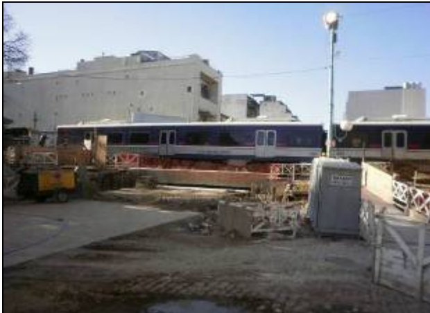
Bajo Pedraza vista hacia el Este, paso del tren sobre la estructura definitiva del puente sobre el túnel aún no excavado.
