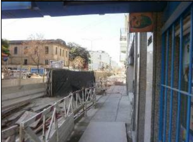
Bajo Pedraza vista hacia el Oeste, calle de convivencia lado Norte en construcción.
