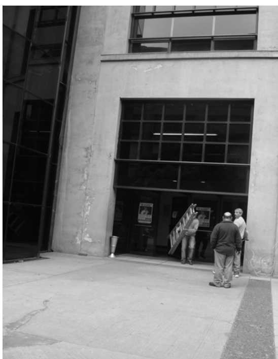
Foto N° 20: Vista del frente del edificio por el que se accede a este Organismo.
