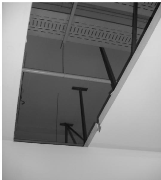
Foto N° 9: Vista de un sector del cielorraso donde podemos observar, por encima del cielorraso armado, el sobretecho de más de dos metros de altura por donde pasa toda la infraestructura de servicios.
