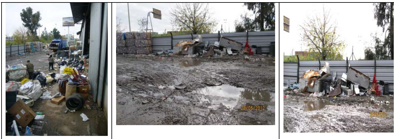
Fotos N° 10, 11 y 12: Acceso al Predio y Playa de maniobras.
