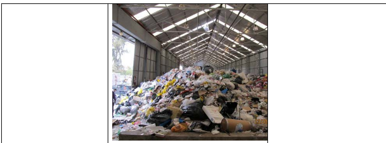
Foto N° 13: Deficiencia en la iluminación artificial.
