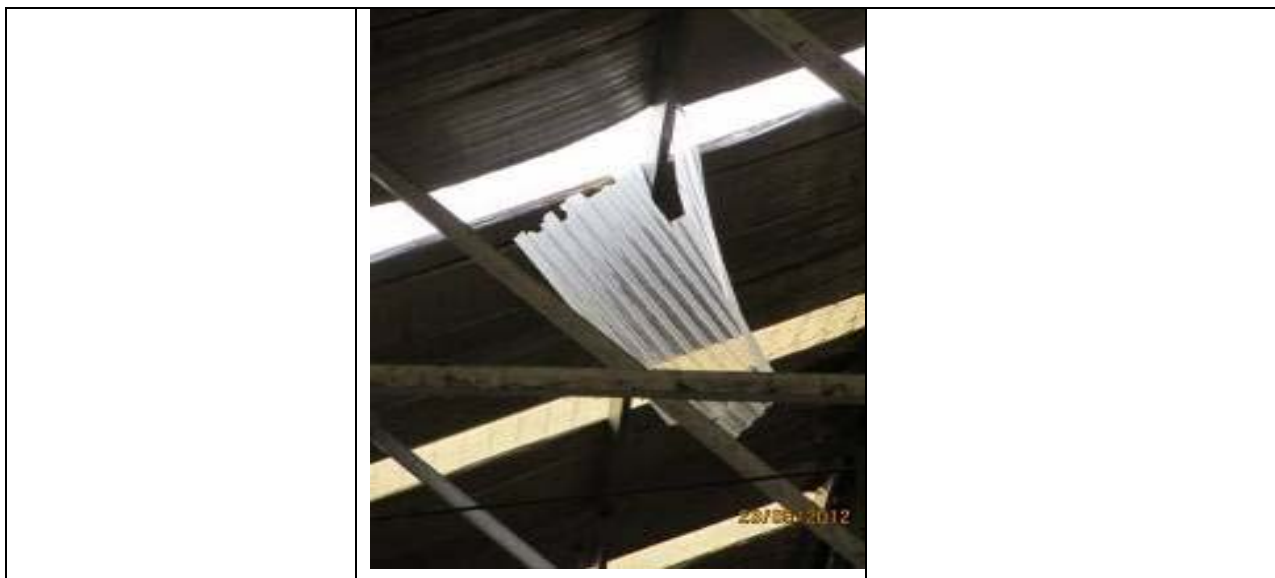
Foto N° 14: Chapas de policarbonato del techo faltantes y averiadas con riesgo de caída, poniendo eventualmente en situación de riesgo al personal que opera en el lugar. Asimismo, la ausencia de las piezas provoca la exposición del personal, material y las maquinarias a las inclemencias del tiempo.
