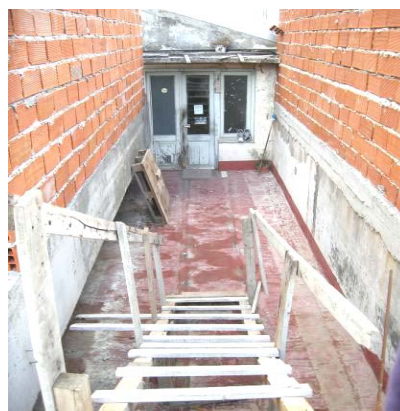
Único acceso a la vivienda del portero.
