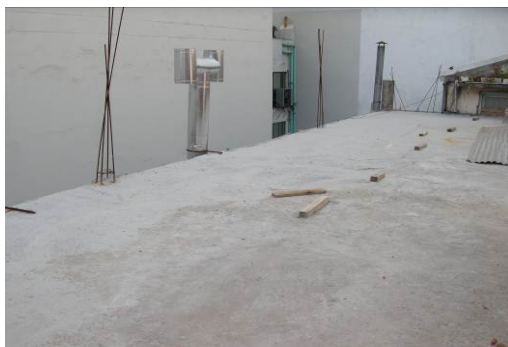
Sectores de obra en el 2º piso sin la protección reglamentaria para evitar la caída al vacío.
