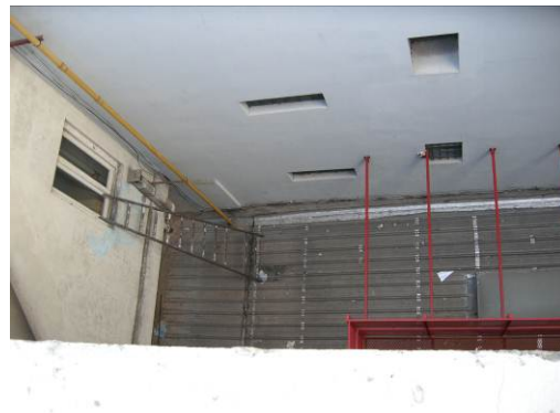
Sectores de obra en el 2º piso sin la protección reglamentaria para evitar la caída al vacío.
