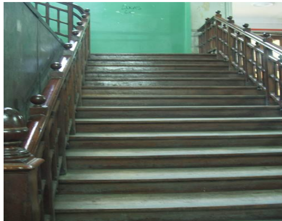
Escaleras de madera originales del edificio histórico.
