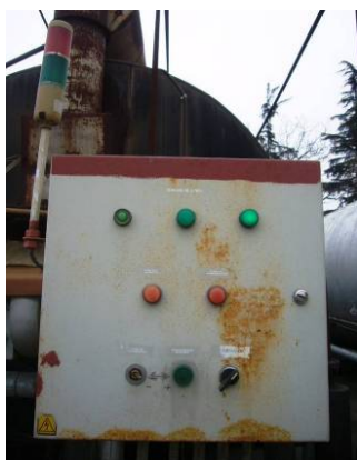
Foto N° 23: Instalaciones y detalles de instalaciones eléctricas a la intemperie y no actualizadas, algunas en exterior y en interior.
