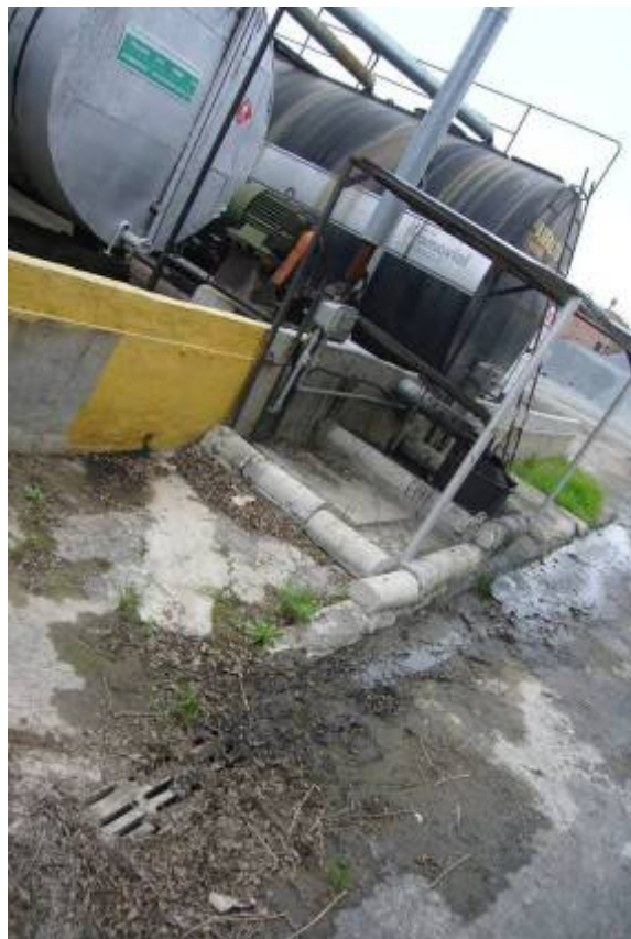
Foto N° 25: Descarga en el desagüe pluvial.
