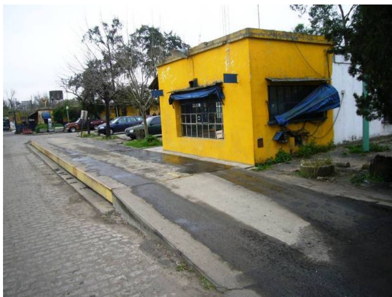
Foto N° 19: La báscula para el peso de camiones se encuentra en funcionamiento. Los camiones son identificados y pesados al egreso de la planta. Se hacen cuatro copias, una para el transporte, otra para la planta y dos para el lugar de llegada del camión con el producto elaborado.
