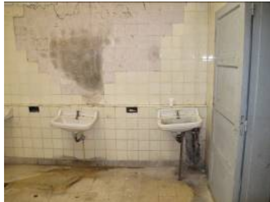
Foto 66: Sanitarios públicos. Galería XVII.
