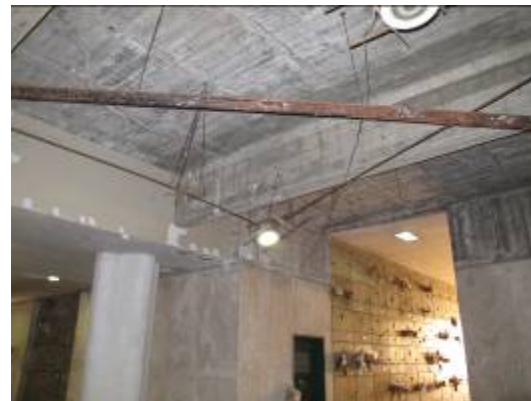
Foto 60: Ejecución de cielorrasos suspendida.
