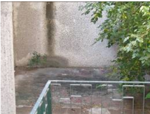
Foto 37: Patio interior inundable.
