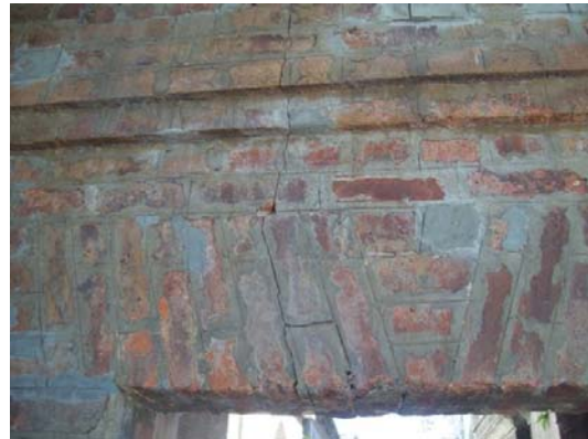
Foto 22: Dintel acceso Capacidades Diferentes.
