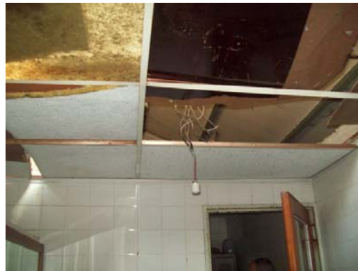
Foto 29: Cielorraso de los Vestuarios.
