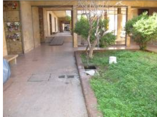
Foto 64: Exterior de galerías.
