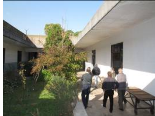
Foto 24: Exterior de galerías.
