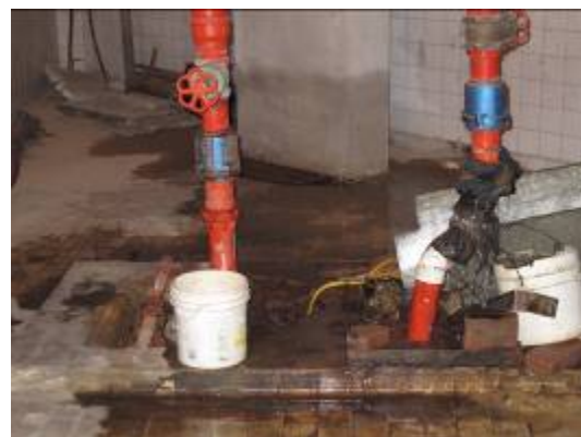
Foto 42: Bombas depresoras de napa freática. Galería XVI.
