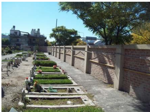
Foto 17: Vista de muro Av. Castañares.
