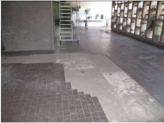
Foto 69: Solados deteriorados.
