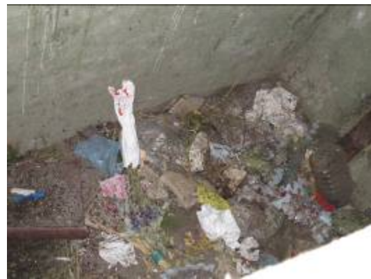
Foto 40: Piso de caja de ascensor porta – ataúdes.
