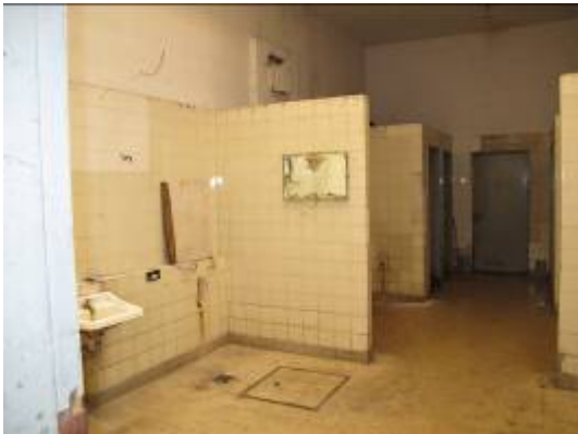
Foto 65: Sanitarios públicos. Galería XVII.
