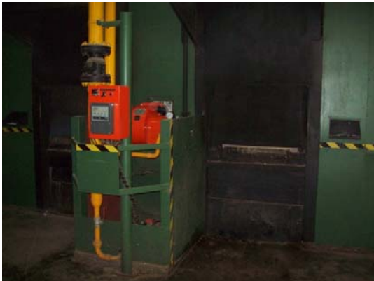
Foto 10: Hornos. Batería C.
