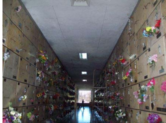
Foto 6: Cielorraso modificado en pasillo de nichos.
