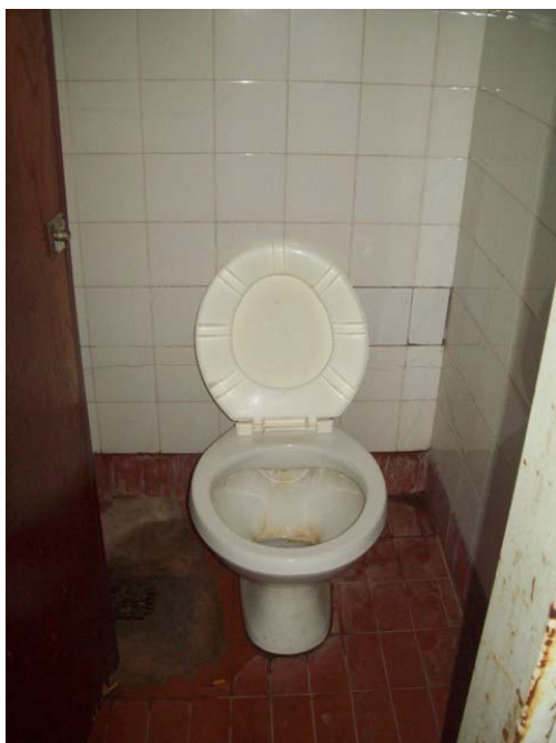
Foto 32: Vestuario. Baños del personal.
