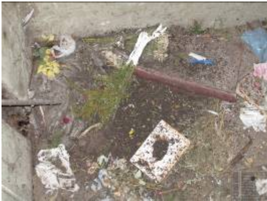
Foto 39: Piso de caja de ascensor porta – ataúdes.
