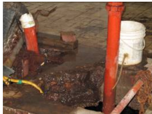
Foto 44: Bombas depresoras de napa freática. Galería XVI.
