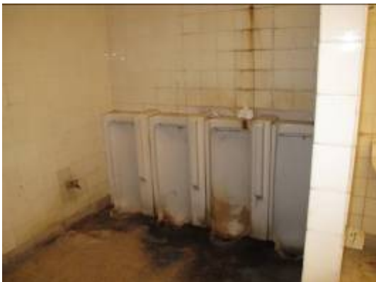
Foto 67: Sanitarios públicos. Galería XVII.
