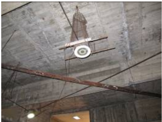
Foto 59: Ejecución de cielorrasos suspendida.
