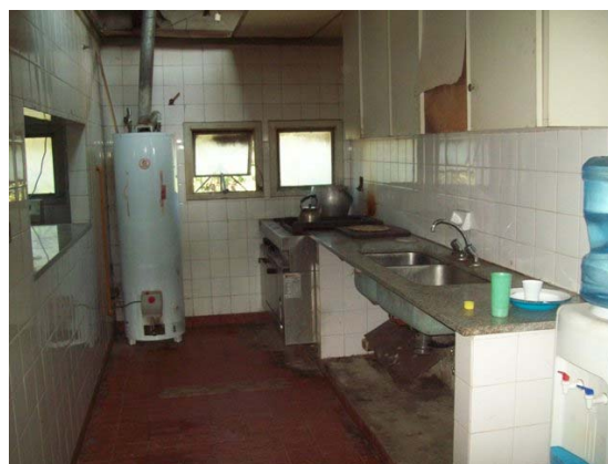
Foto 35: Vestuario. Zona de cocina.
