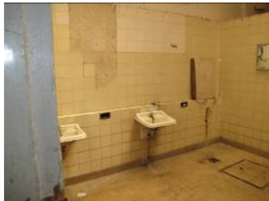
Foto 68: Sanitarios públicos. Galería XVII.
