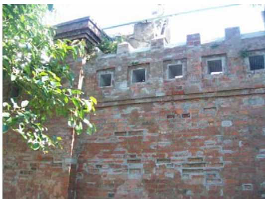
Foto 15: Vista del Muro exterior.
