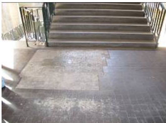
Foto 31: Solados deteriorados.
