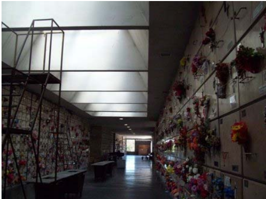
Foto 5: Iluminación cenital original.
