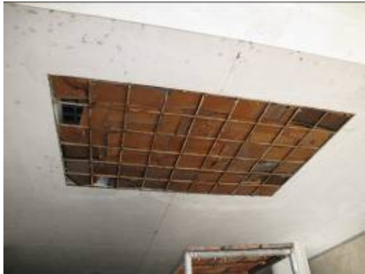
Foto 27: Reparación de cielorrasos suspendida.
