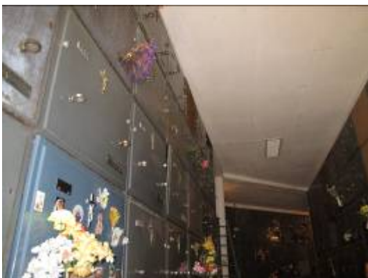
Foto 25: Nichos con tapas metálicas.
