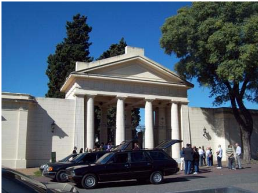
Foto 21: Antiguo acceso. Peristilo y Capilla.
