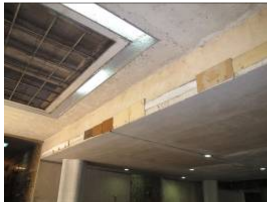
Foto 62: Ejecución de cielorrasos suspendida.
