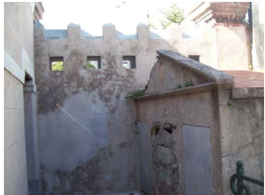
Foto 14: Vista del Muro interior.
