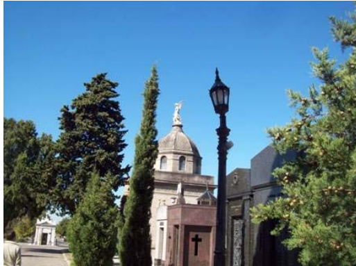
Foto 28: Luminarias afectadas por robo.
