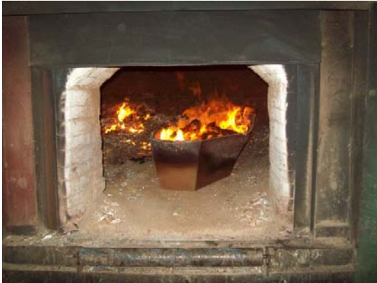
Foto 16: Cremación en Caja Metálica.
