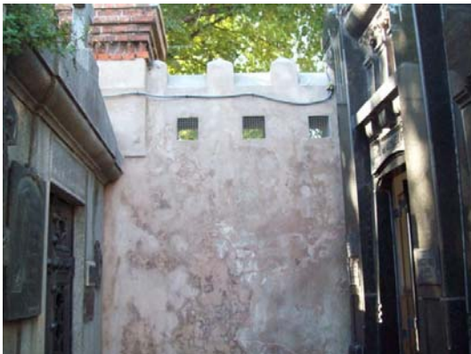
Foto 13: Vista del Muro interior.
