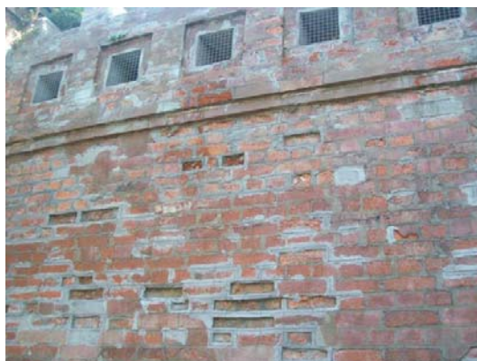
Foto 16: Vista del Muro exterior.
