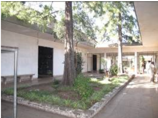
Foto 23: Exterior de galerías.
