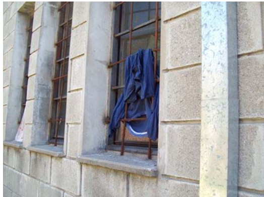
Foto 14: Ventanas vestuario personal operativo.
