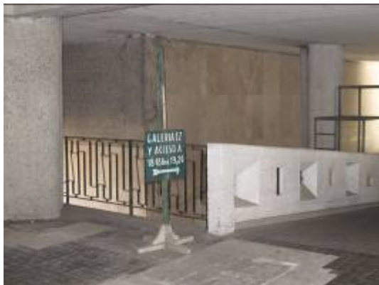
Foto 29: Solados deteriorados.
