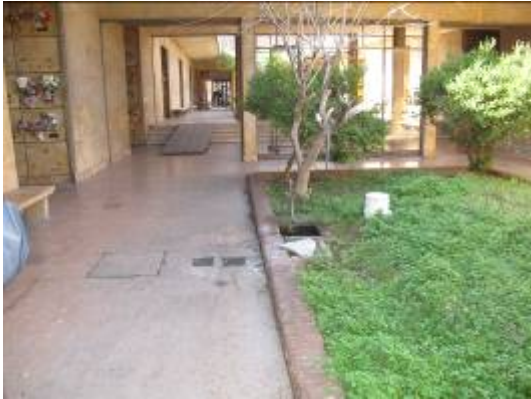
Foto 63: Exterior de galerías.
