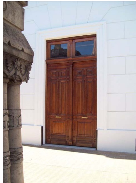
Foto 6: Peristilo interior. Puertas reacondicionadas.
