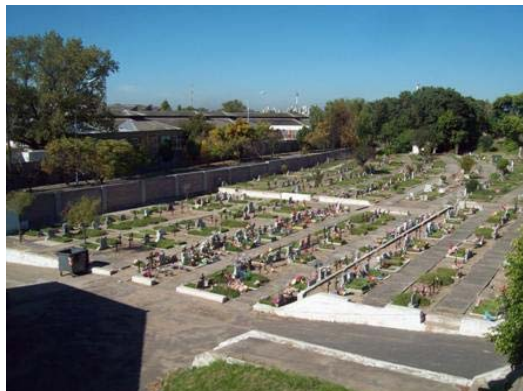
Foto 16: Vista de muro Av. Castañares.
