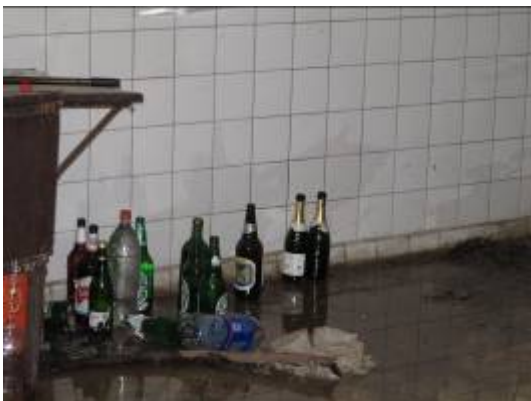
Foto 43: Sala de bombas depresoras de napa. Galería XVI.
