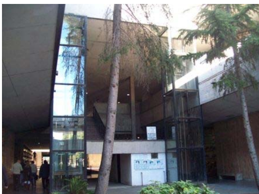
Foto 1: Vista de los ascensores sector nichos.
