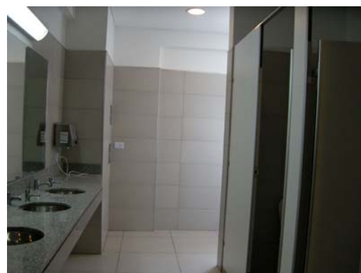
Vista de los sanitarios de uso público.
