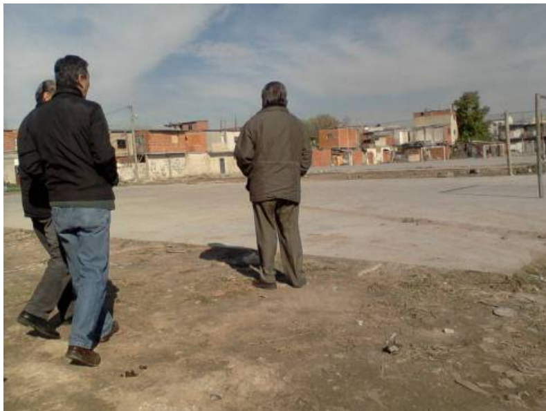
Foto 13: Predio de obra sin intrusión
