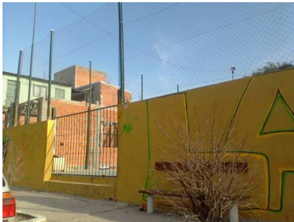
Foto 15: Acceso a predio de obra
