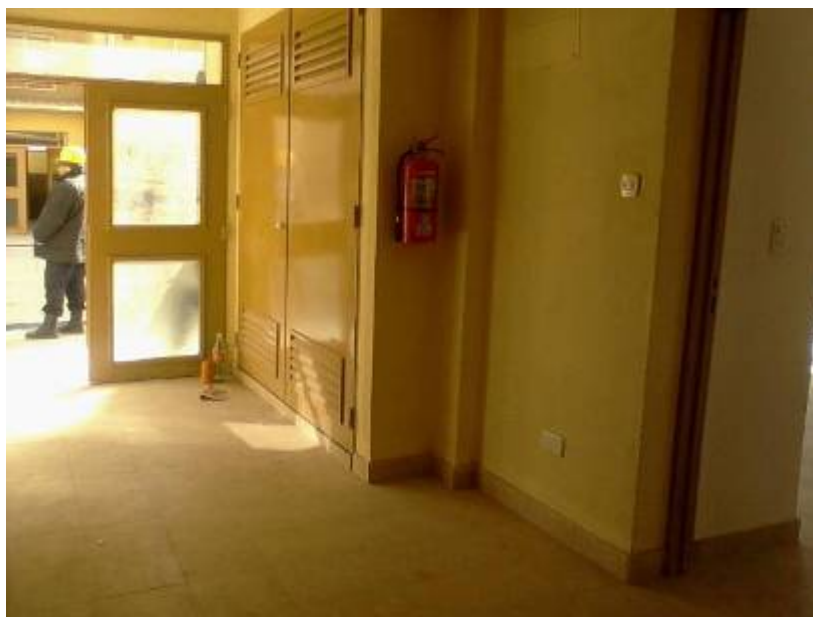
Foto 3: Hall de acceso Módulo 4
