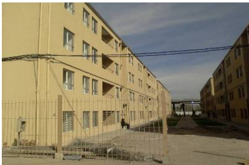
Foto 1: Espacio intermodular – Módulos 4 - 5
