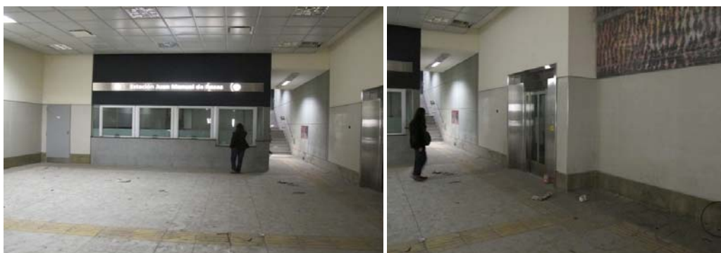
Boleterías. No contempla el sector el “orden y limpieza”. Ascensores. No contempla el sector el “orden y limpieza”.
