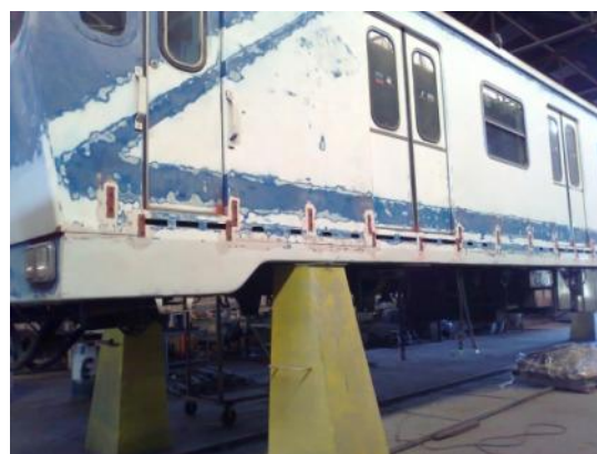
Adaptación solapas coche – andén (Preparación).
