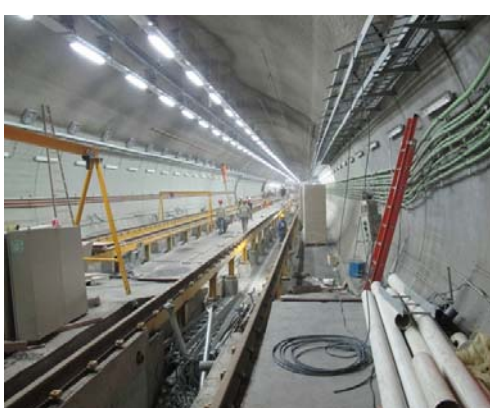
Vista de caverna de cochera con terminación gunitado. Vista del andén estación Juan Manuel de Rosas.
