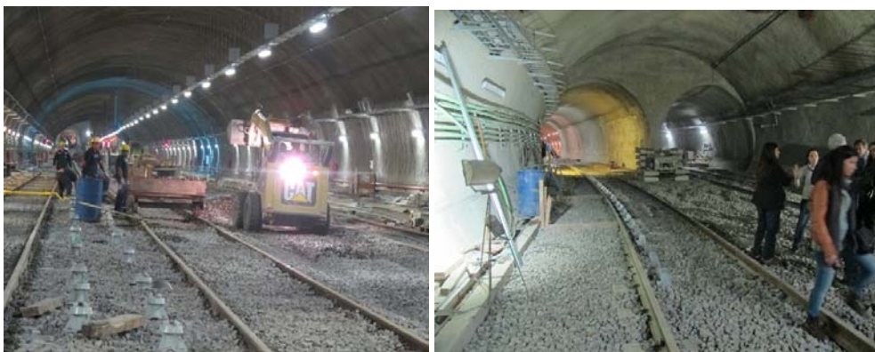
Vista doble túnel por paso interferencia conducto Aysa. Acceso a Cochera desde Estación Juan Manuel de Rosas.
