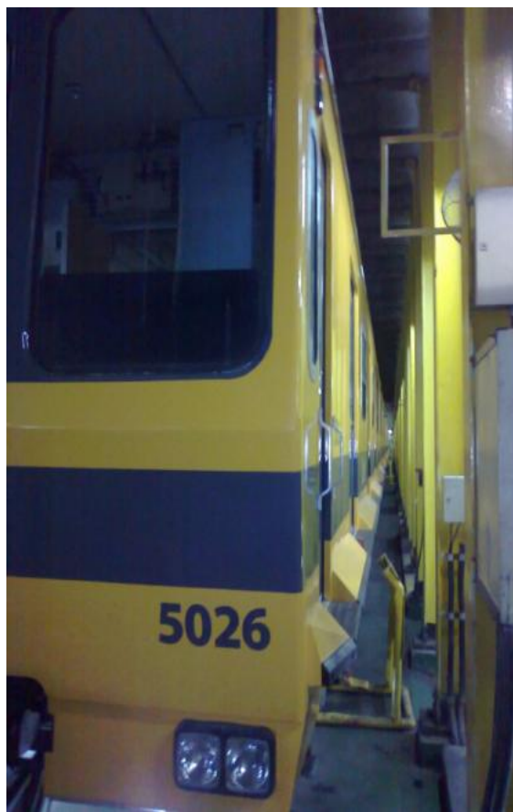
Primer coche de formación. Véase protección de patines de contacto al tercer riel.
