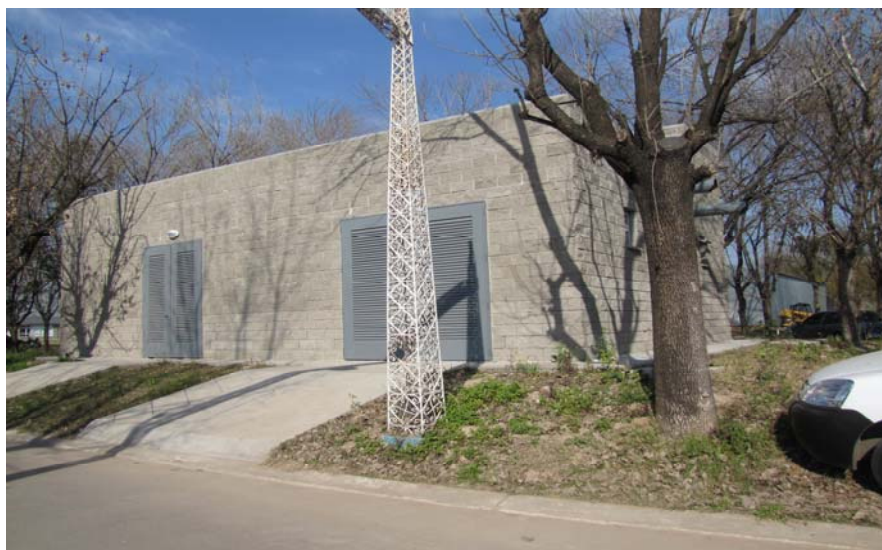
Foto N° 18 – Instalaciones donde se encuentran los transformadores de electricidad de media tensión, ubicado en el camino que va desde la guardia.
