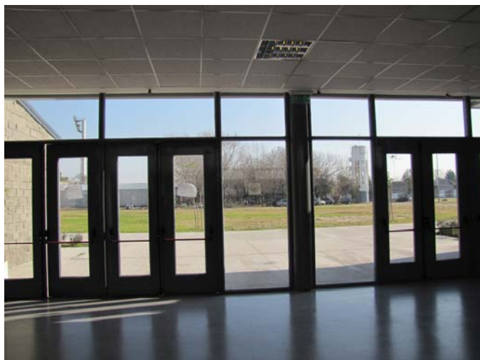
Foto N° 1 – Entrada, vista desde el interior de la parte administrativa, edificación nueva.
