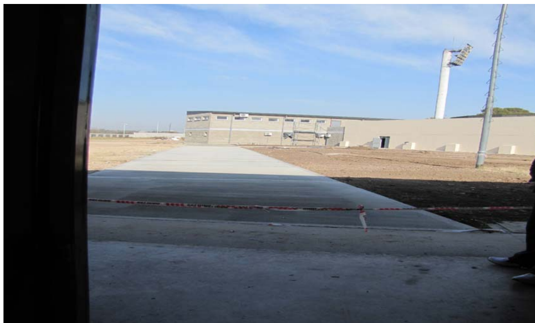
Foto N° 13 – Vista desde el sector de enseñanza hacia el gimnasio y el lugar de practicas de tiro.
