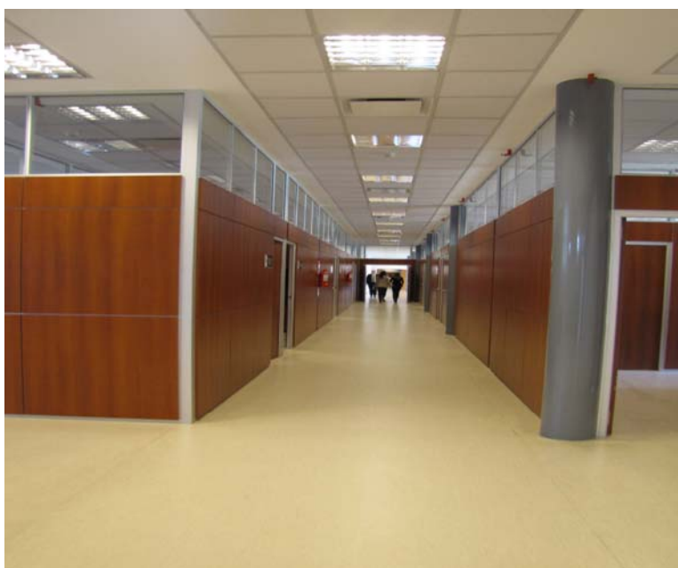
Foto N° 2 – Dentro del sector administrativo se puede observar un pasillo central al que concurren las diferentes oficinas. Todas las divisiones están realizadas con tabiques compuestos en cuyo interior se encuentran las instalaciones, de electricidad, sistemas, etc. Luminosidad natural y artificial, servicios de aire acondicionado, detectores de humo contra incendio y matafuegos (con la carga vigente) con distribución adecuada
