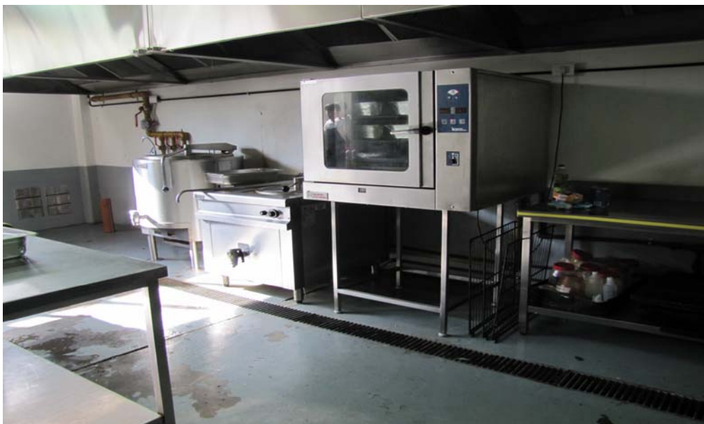
Foto N° 25 – Vista interior de la cocina
