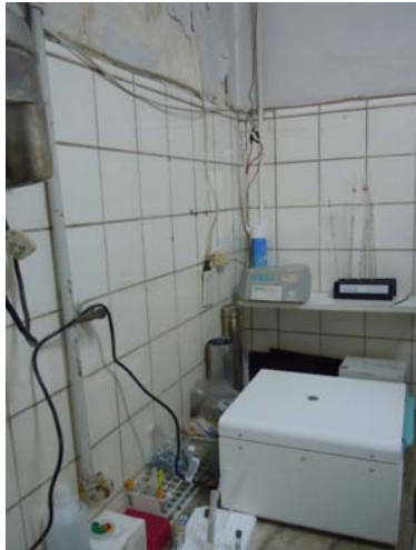
SISTEMA ELECTRICO EN MALAS CONDICIONES
