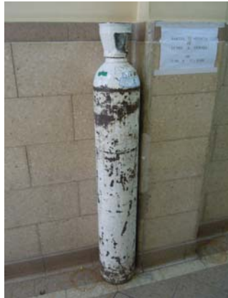
TUBO DE OXIGENO SIN CADENA DE SEGURIDAD
