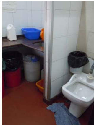
ATENCION CON FALTA DE PRIVACIDAD, UN SOLO BAÑO (originalmente chatero)
