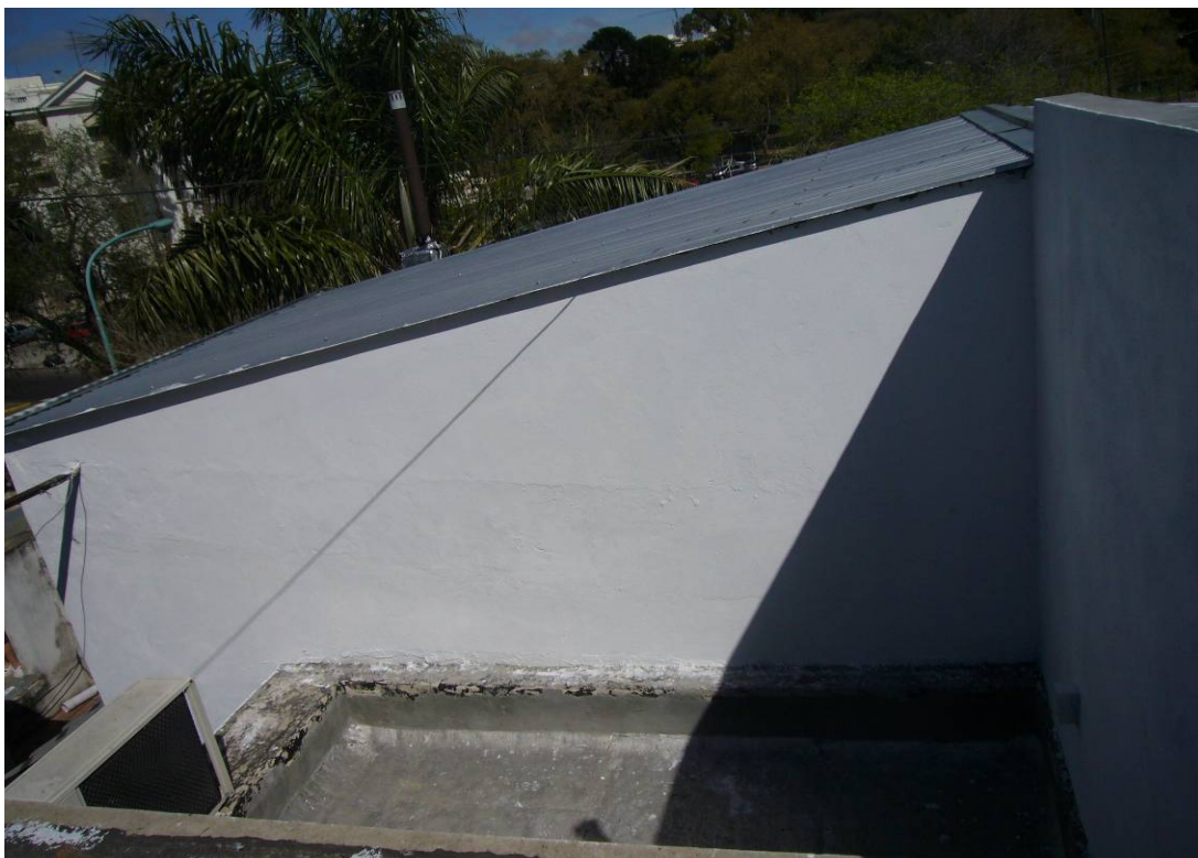
Foto 33. Techo nuevo con inversión de las pendientes
