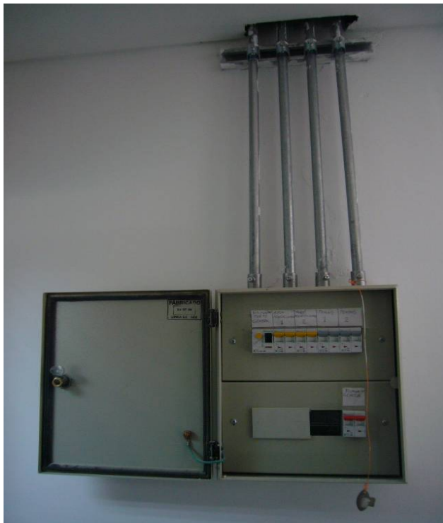
Foto 19. Tablero eléctrico
