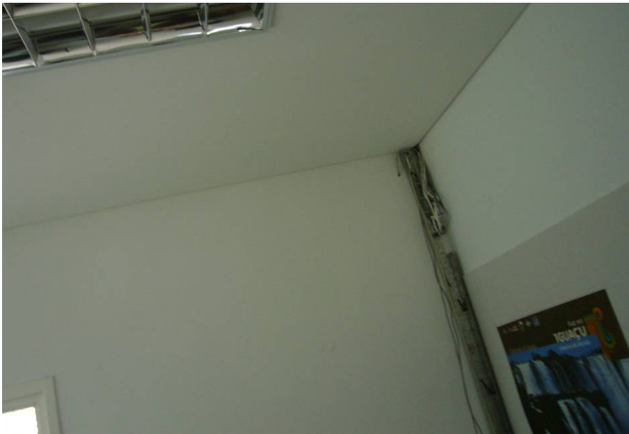
Foto 18. Cables a la vista
