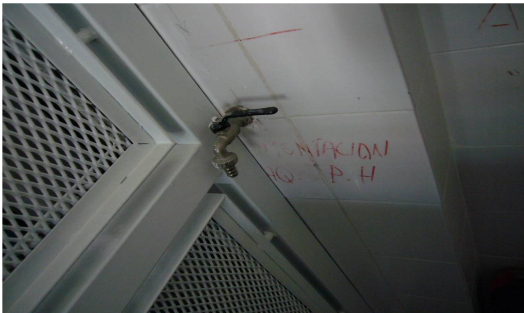
Foto 15. Grifo desplazado sobre carpintería.
