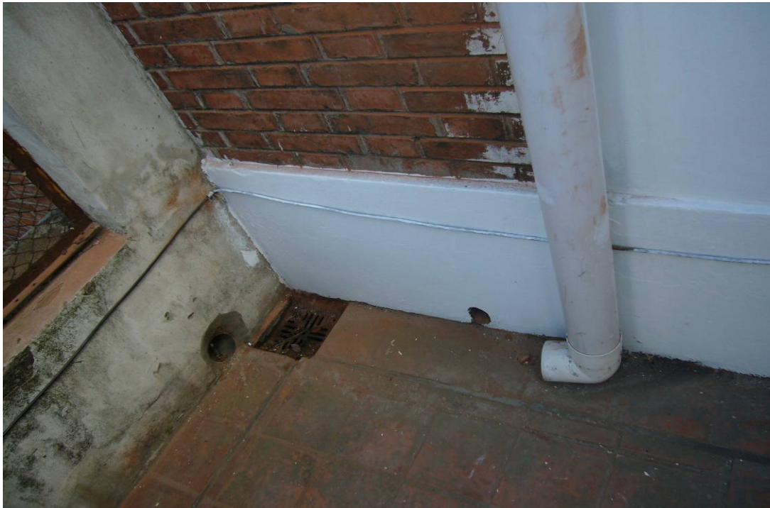
Foto 44. Llegada de desagüe del techo nuevo
