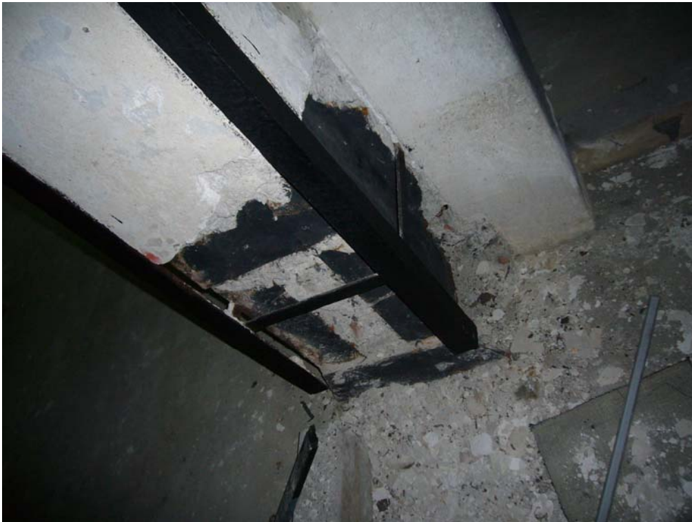
Foto 22: Estructura de la columna luego del retiro parcial del contrapiso y revestimiento de mampostería.
