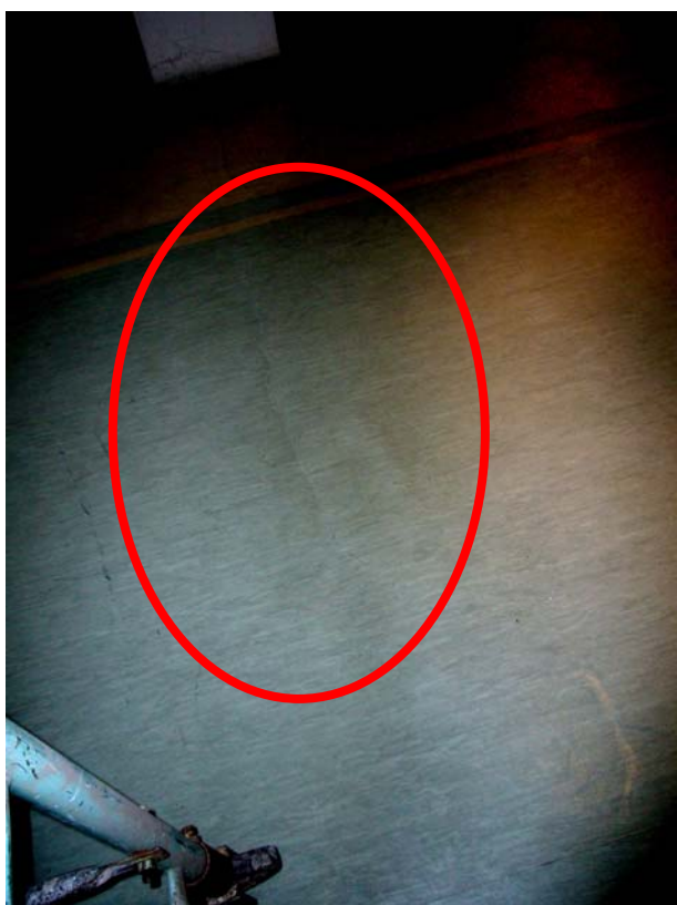
Foto 21: Piso del hall de entrada del Edificio
