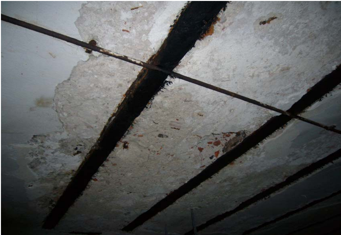
Foto 10: Perfiles de la bovedilla luego de ser pintados. El auditado ignora el origen de la obra.
