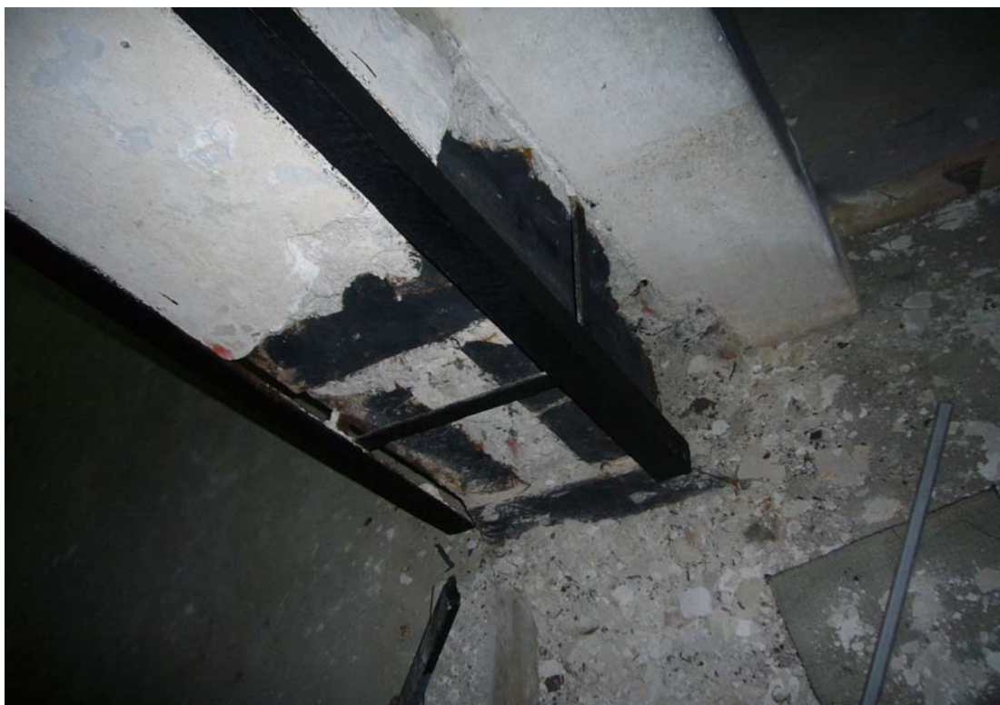
Foto 17: Despeje parcial de la estructura
