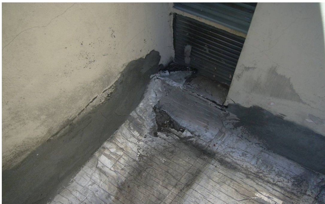
Foto 52. Corte en la membrana
