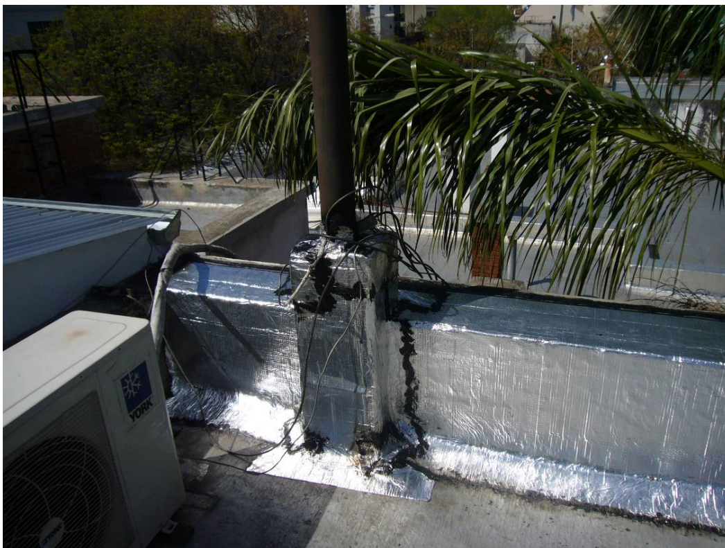
Foto 34. Agregados de membrana sobre muros por filtraciones
