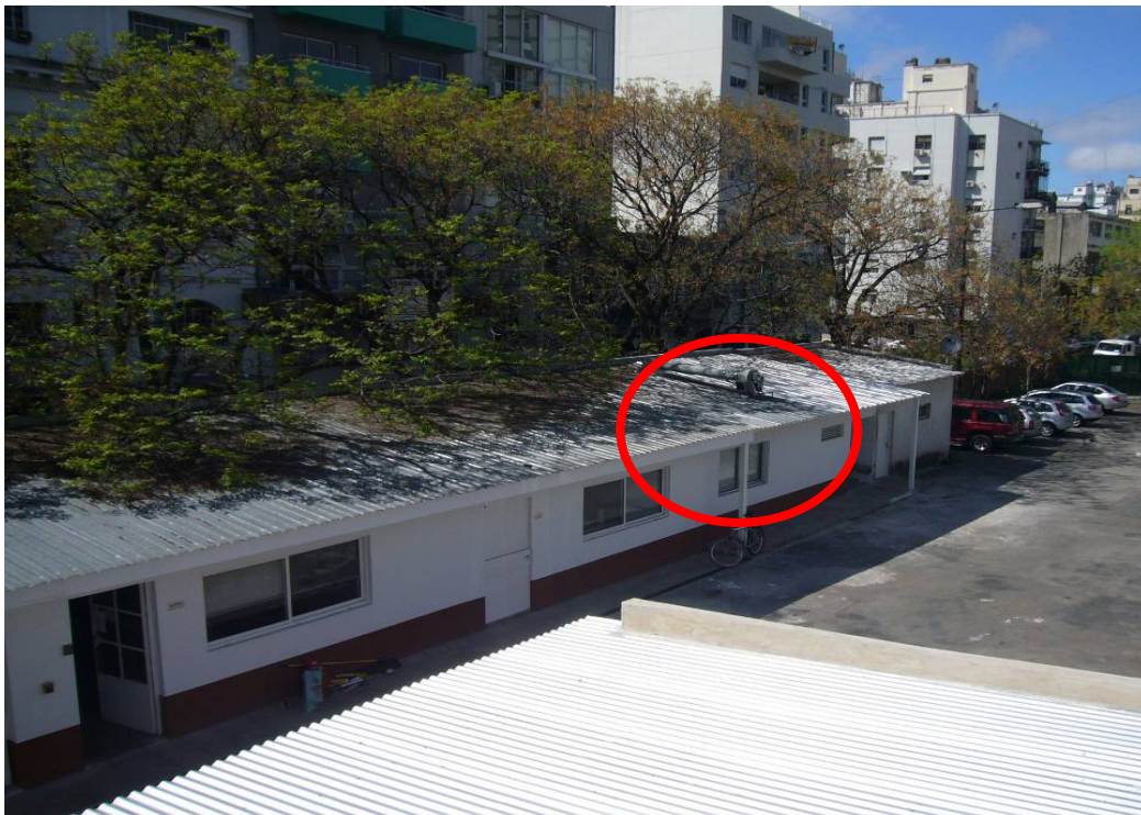
Foto 26. Agregado a las construcciones existentes.
