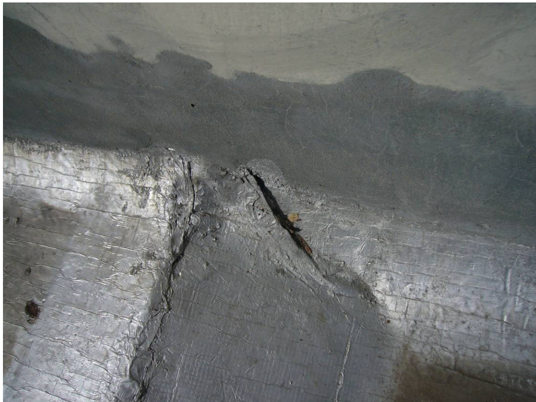
Foto 53. Corte en la membrana
