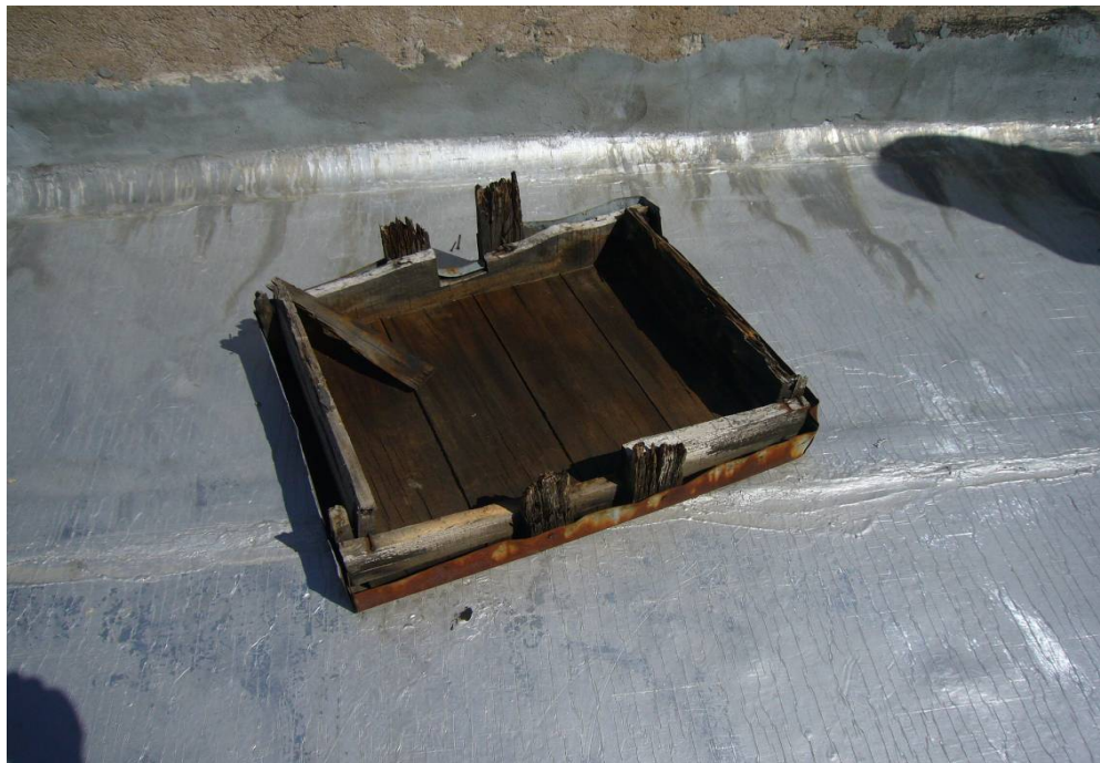
Foto 59. Tapa retirada de lucarna.
