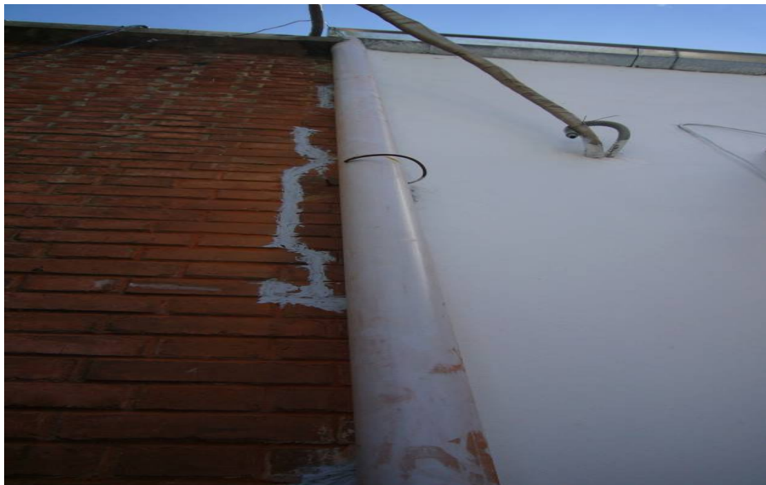
Foto 43. PVC de limitada resistencia a los rayos ultra violeta
