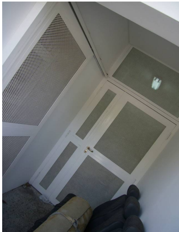
Foto 22. Puertas de reja (chapa desplegada)
