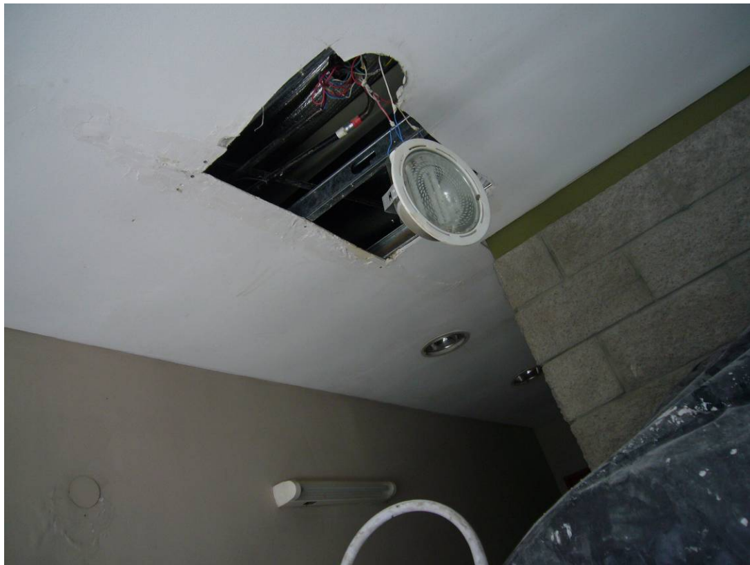
Foto 51. Reparaciones en curso
