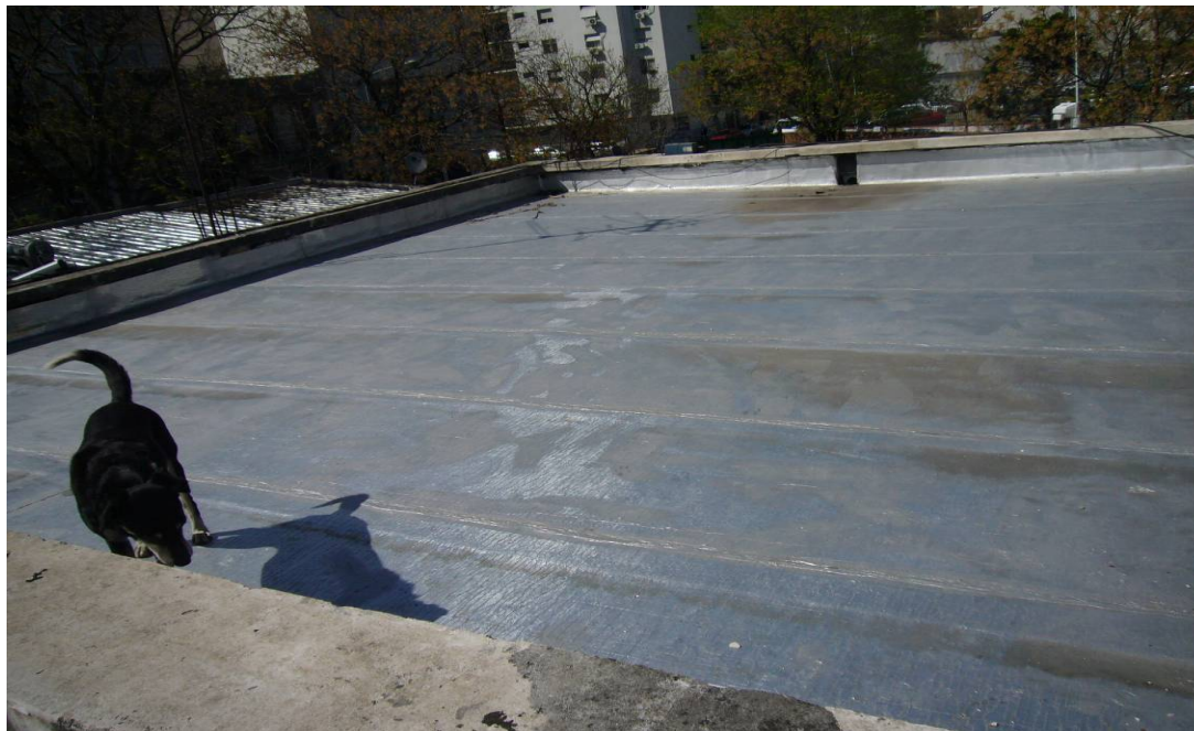
Foto 27. Aplicación de membranas sobre techos del edificio original.
