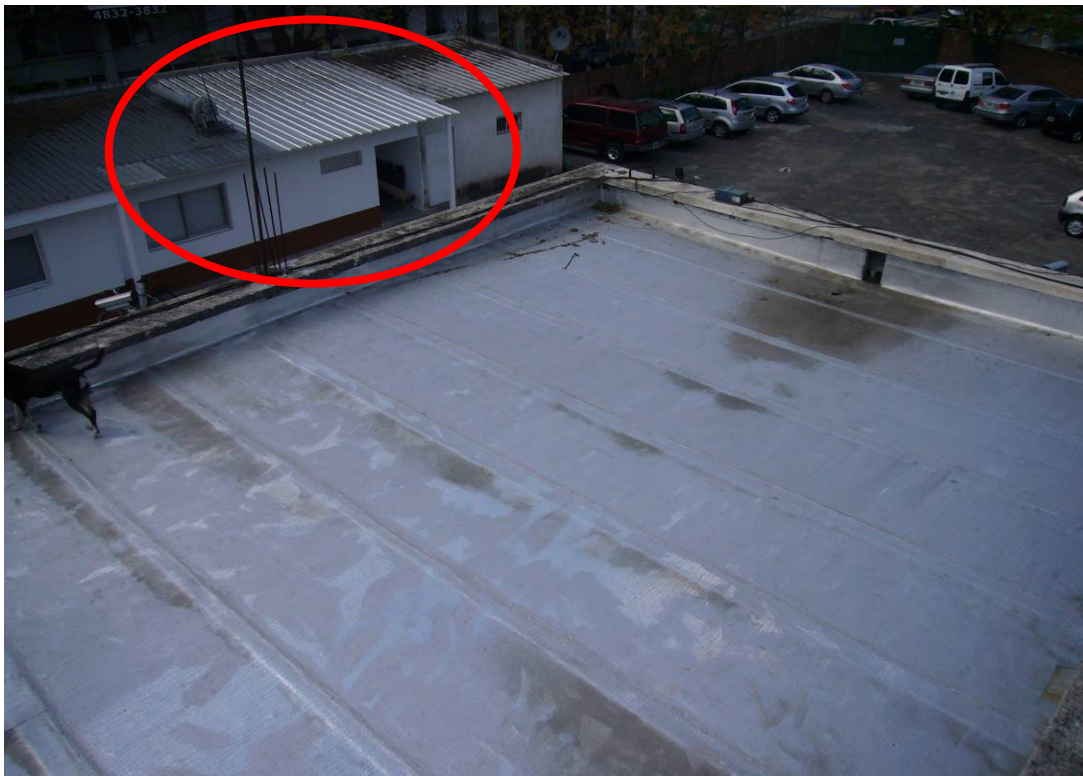
Foto 30. Azotea parcial y ampliación.
