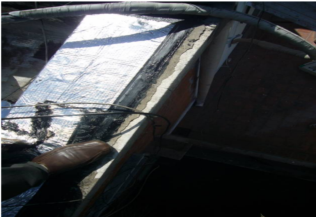
Foto 41. Membrana sobre mampostería
