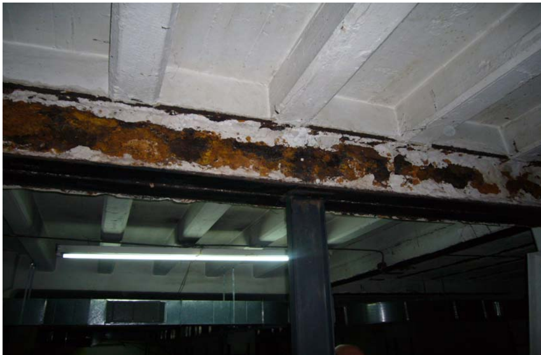
Foto 14: Apuntalamiento de viga con acero
