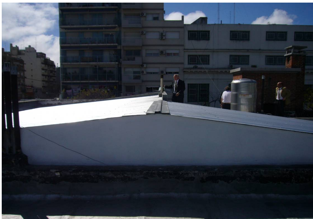
Foto 35. Techo nuevo en reemplazo del anterior,
