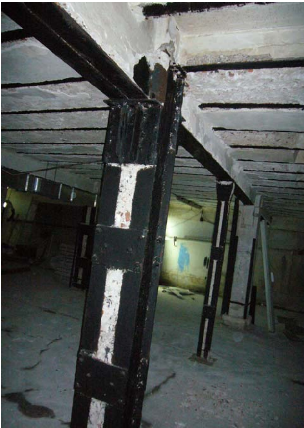
Foto 13: Estructura con retiro parcial de revestimientos
