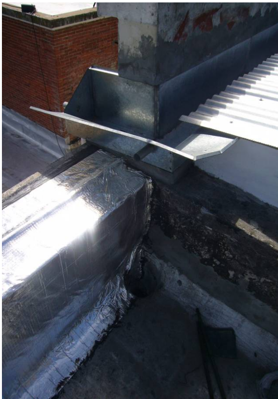
Foto 37. Desviación de pluviales hacia terrazas existentes
