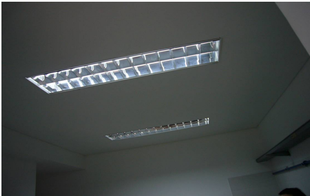
Foto 9. Cielorraso y artefactos de iluminación
