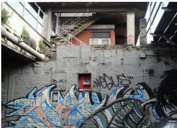
Foto 1 Obra "Reacondicionamiento del bajo puente sobre calle Anchorena y vías del FFCC Sarmiento"
