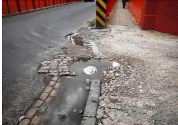
Foto 7 Obra “Acondicionamiento de Puentes sobre vías FFCC Sarmiento Salguero, Bulnes, M. Bravo, Billingursth, Ambrosseti y Medrano”
