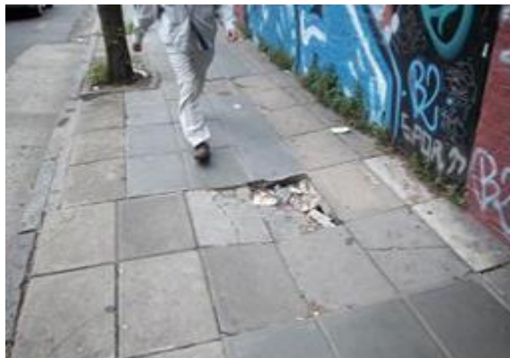
Foto 6 Obra “Acondicionamiento de Puentes sobre vías FFCC Sarmiento Salguero, Bulnes, M. Bravo, Billingursth, Ambrosseti y Medrano”
