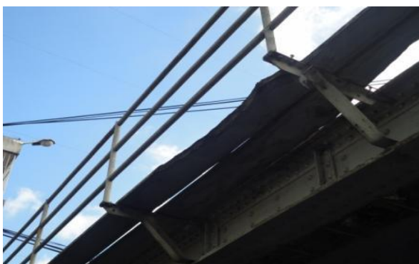
Foto 2 Obra "Reacondicionamiento del bajo puente sobre calle Anchorena y vías del FFCC Sarmiento"
