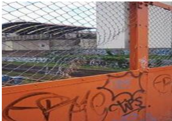
Foto 5 Obra “Acondicionamiento de Puentes sobre vías FFCC Sarmiento Salguero, Bulnes, M. Bravo, Billingursth, Ambrosseti y Medrano”
