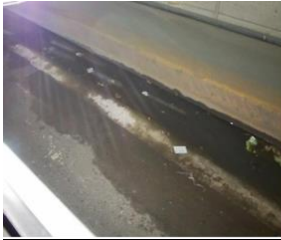
Foto 4 Obra “Pintura del Túnel Libertador”
