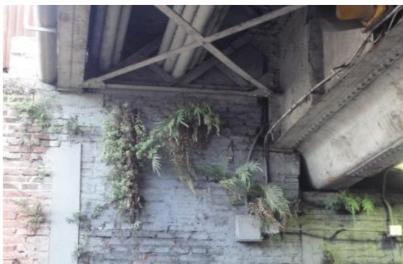
Foto 3 Obra "Reacondicionamiento del bajo puente sobre calle Anchorena y vías del FFCC Sarmiento"
