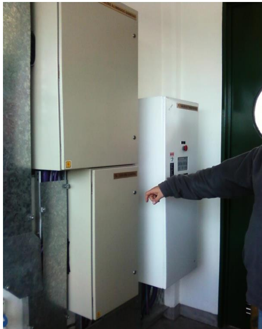
Foto N° 10: Vista del puente giratorio Cecilia Grierson. Sistema de computación para el manejo del Puente Giratorio. Sistema energético a 380 voltios.
