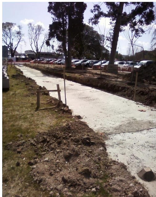
Foto N° 8: Obra de la Plazoleta Fenia Chertcoff, en plena etapa de ejecución a fecha de la entrevista.
