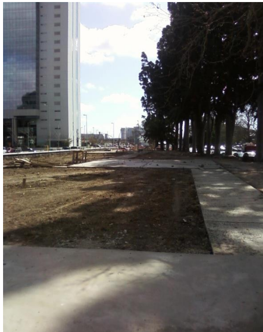
Foto N° 7: Obra de la Plazoleta Fenia Chertcoff, en plena etapa de ejecución a fecha de la entrevista.
