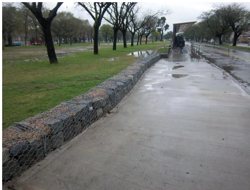
Foto 5 – Muro de Gaviones – Metrobús Corredor Sur
