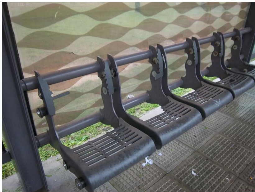
Foto N° 1 - Apoya brazos rotos – Metrobús Corredor Sur
