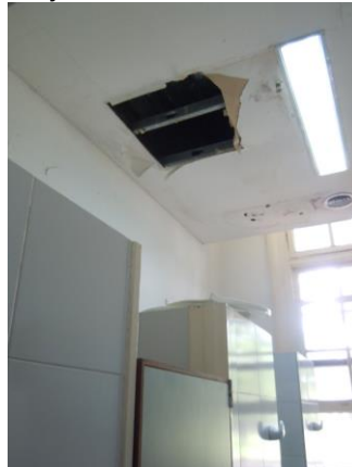
Baños de planta baja con filtraciones
