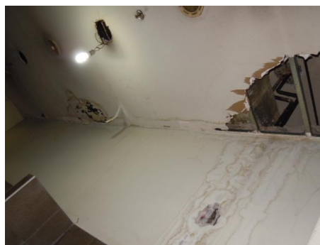
Baños en mal estado y filtraciones
