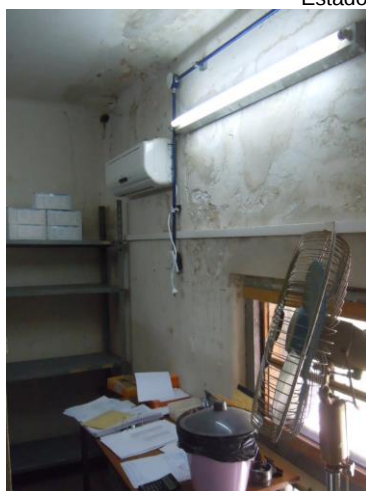
Humedades e instalación eléctrica nueva
