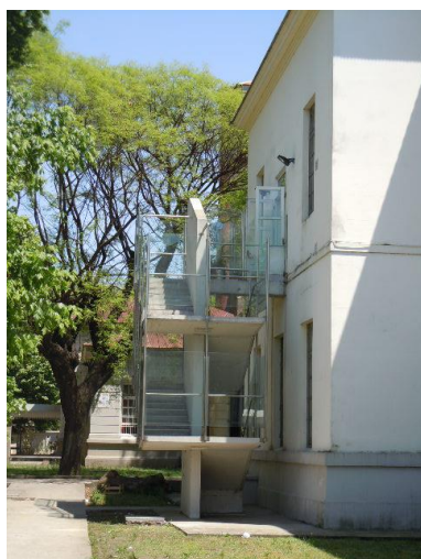
Escalera de emergencia sin protecciones superiores
