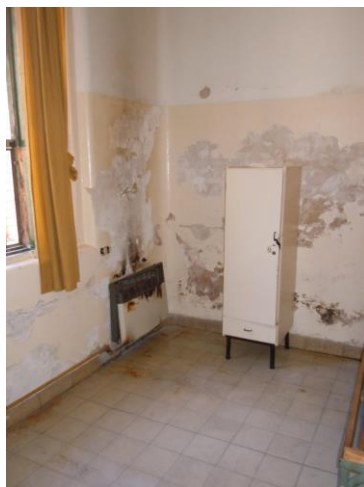
Paredes en mal estado con filtraciones y falta de pintura
