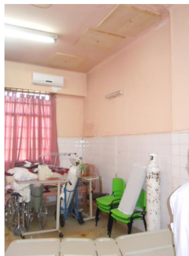
Sala de Internación, filtraciones en cielorrasos
