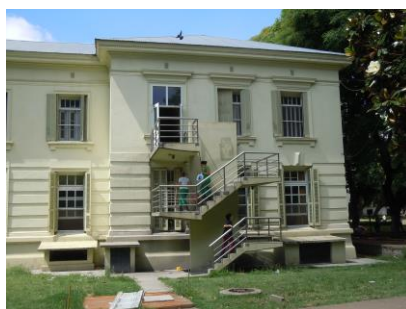
Salida de emergencia sin protecciones adecuadas
