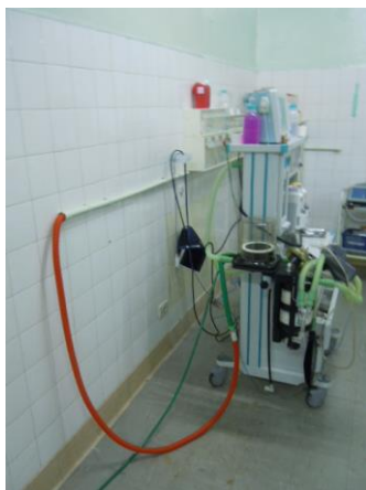
Aspiración de gases conectado en forma precaria, transferencia regular
