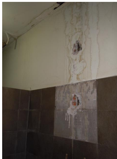
Baños en mal estado y filtraciones
