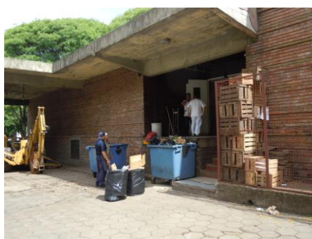
Sector de residuos en regulares condiciones
