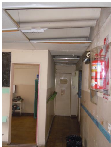
Cielorrasos rotos, baños en malas condiciones falta de privacidad
