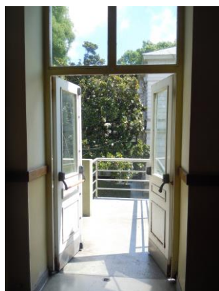
Salida de emergencia sin protecciones adecuadas
