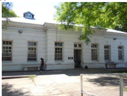
Exterior en buen estado
