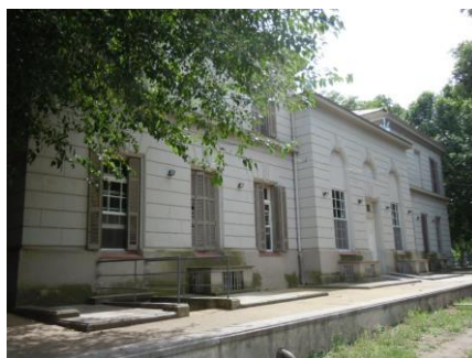
Exterior en buen estado de mantenimiento
