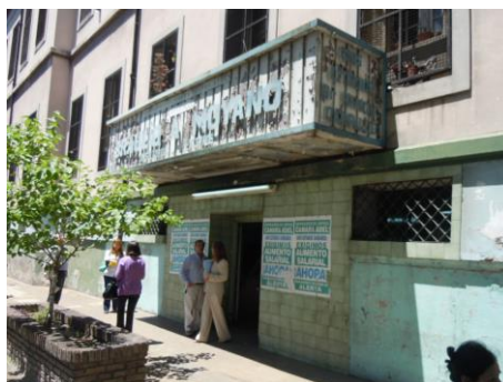
Acceso desde la calle Brandsen
