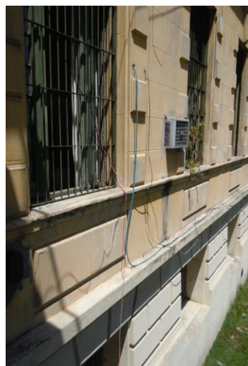
Falta de mantenimiento exterior, instalaciones precarias
