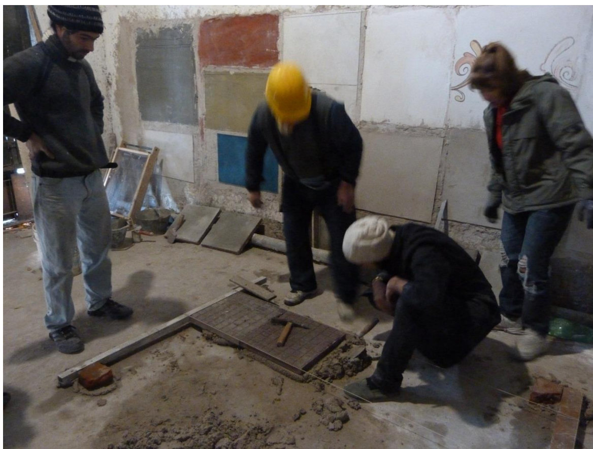
Escuela Taller: Alumnos trabajando en la clase de Albañilería tradicional.
