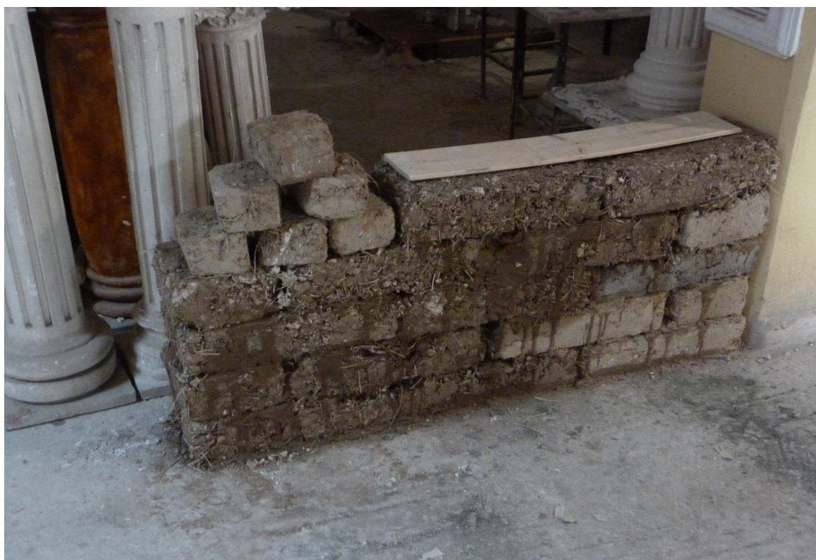
Escuela Taller: Técnica de fabricación de ladrillos de adobe. Muestra de construcción.
