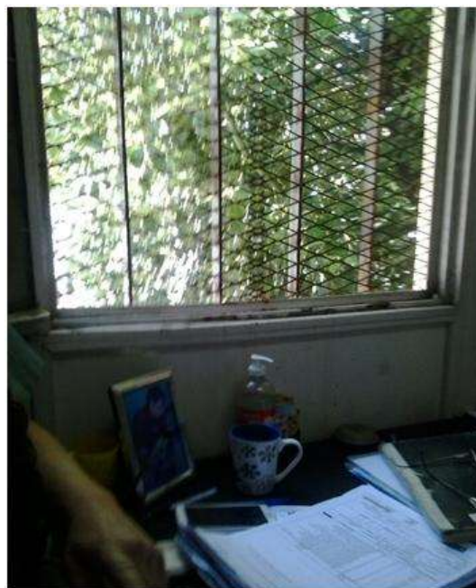
Foto N° 17: CESAC N° 3 Colocación de doble enrejado como protección ante robos o hurtos.
