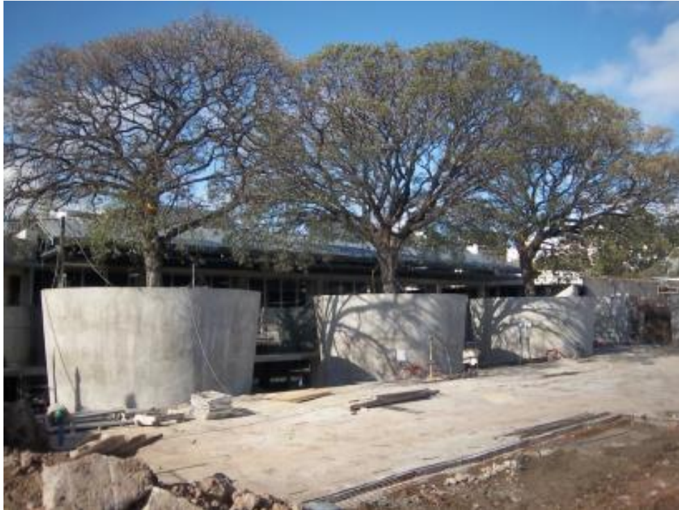
Foto N°1: Acceso al CEC, nivel -3.5 mts
