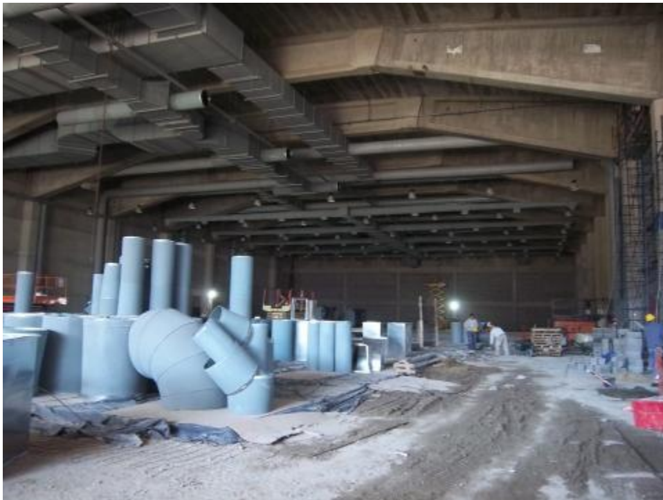
Foto N°4: Sala Principal, nivel -7mts
