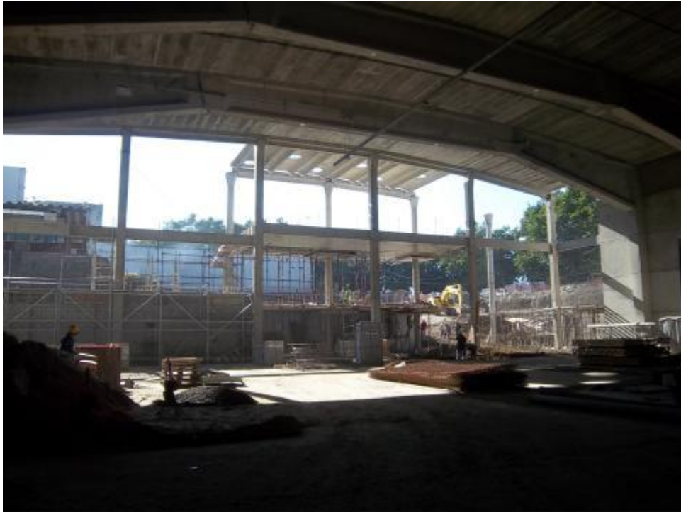
Foto N°5: Sala Principal, nivel -7mts
