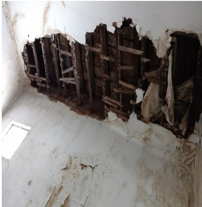
Biblioteca José Hernández. Detalle del techo de la escalera que da acceso a la sala de consulta en el piso superior del edificio.
