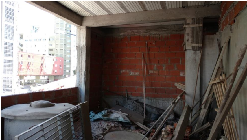
Biblioteca “Hijos del Barrio Piedrabuena”. Vista complementaria del piso superior.
