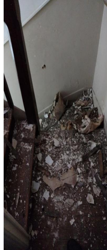
Biblioteca José Hernández. Vista de la escalera que da acceso a la sala de consulta desde el rellano.
