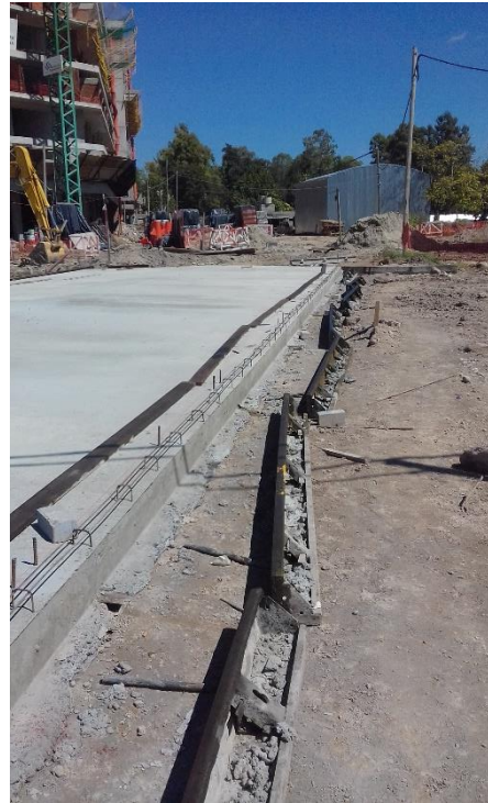
Hormigón de calzada en ejecución.
