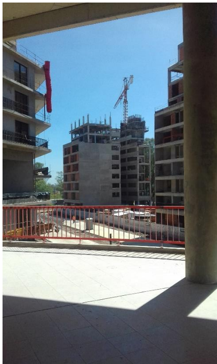
Vista desde espacio común de esparcimiento del edificio.
