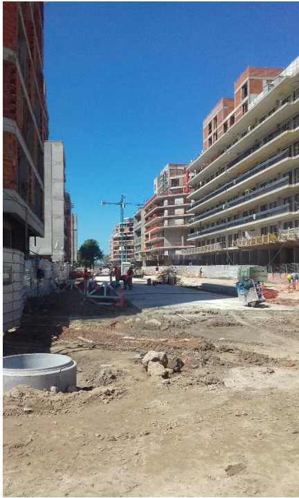
Vista de uno de los ejes del complejo.
