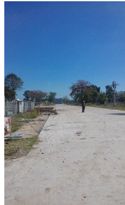
Calzada hormigonada
