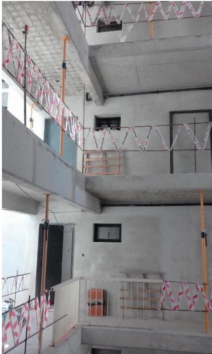
Vista de las barandas de protección para los operarios.
