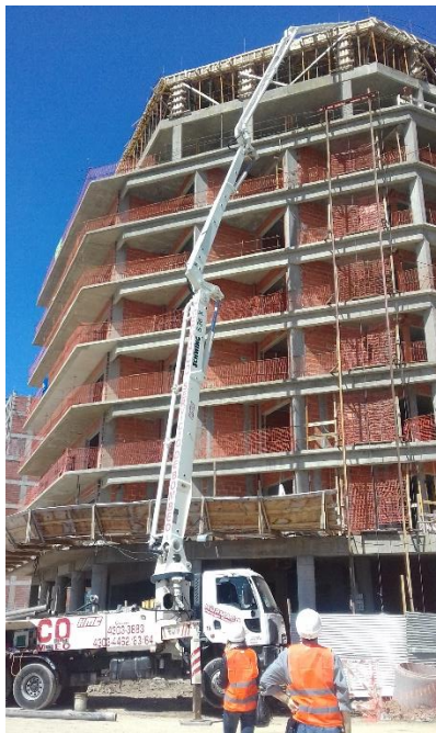
Hormigonado de estructuras.
