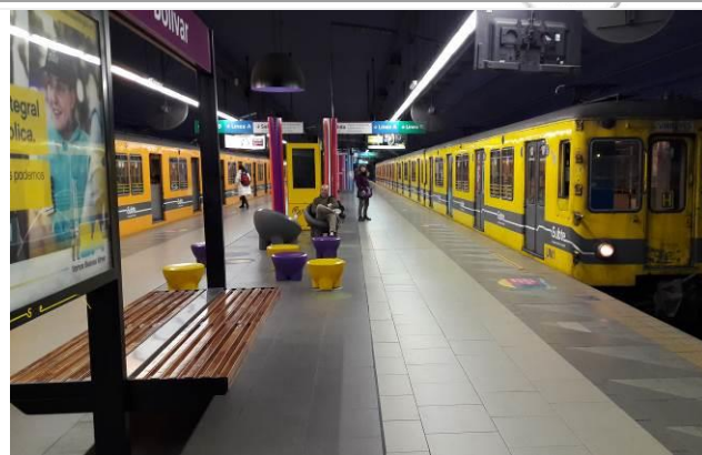
Foto N° 106 Línea E – Est. Bolívar Sobre andén no posee señalización horizontal para no videntes
