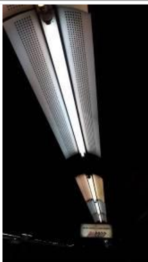
Foto N° 49 Línea C – Est. Independencia Artefactos de iluminación sin protección anti caídas
