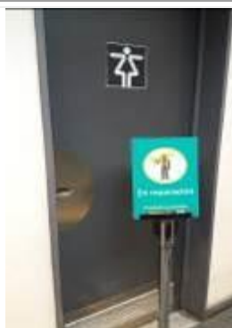
Foto N° 37 Línea H – Est. Hospitales Sanitario Damas en reparación
