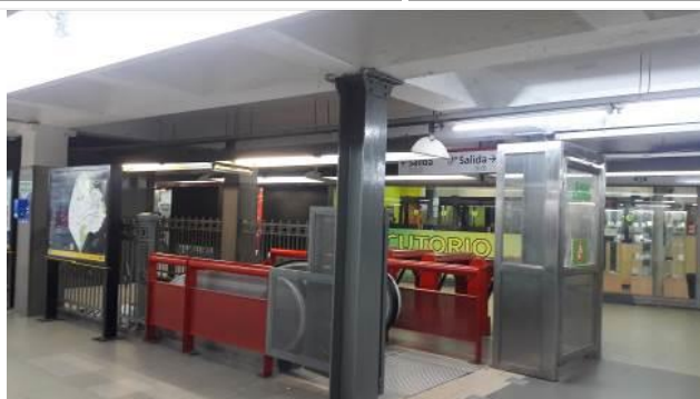
Foto N° 93 Línea B – Est. Leandro N. Alem Falta señalización horizontal para no videntes en hall de la estación
