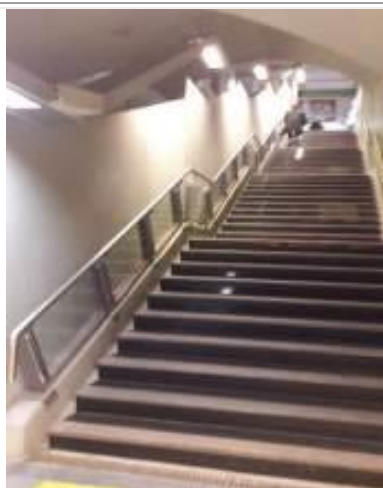
Foto N° 74 Línea H – Est. Santa Fé Aún no fue instalada la escalera mecánica
