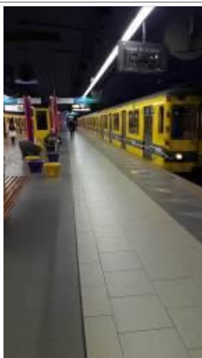
Foto N° 59 Línea E – Est. Bolívar Artefactos de iluminación sin protección anti caídas
