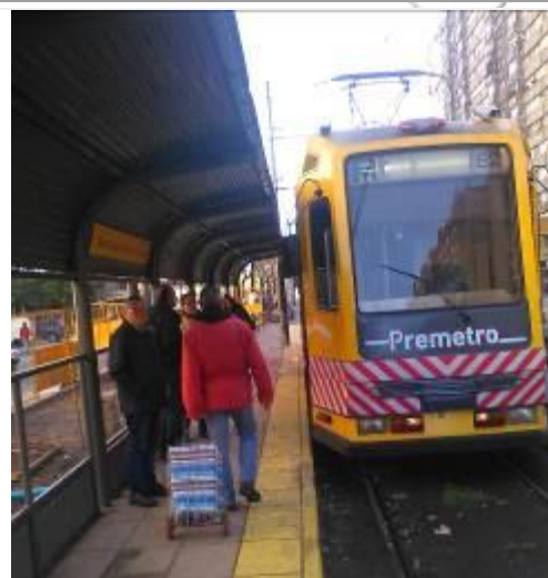
Foto N° 62 Premetro - Centro Cívico Lugano No posee artefactos de iluminación
