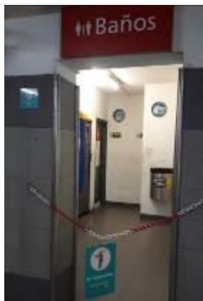
Foto N° 11 Línea B – Est. Leandro N. Alem Sanitarios en reparación
