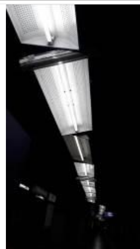
Foto N° 58 Línea E – Est. Independencia Artefactos de iluminación sin protección anti caídas
