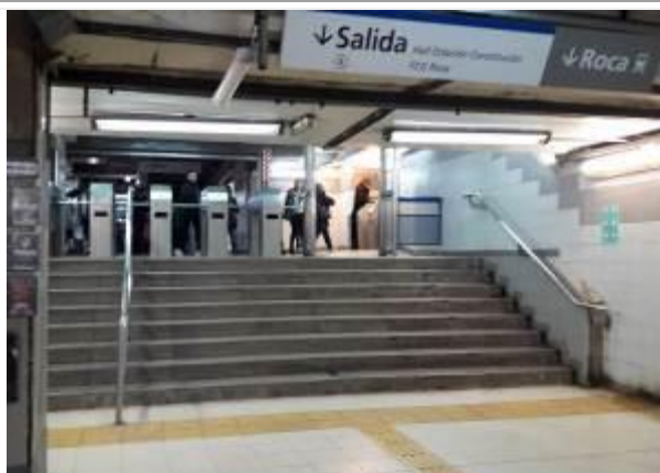
Foto N° 67 Línea C – Est. Constitución Salida al hall estación Constitución ferrocarril Roca No posee circulación vertical para personas con capacidad reducida..
