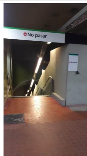
Foto N° 102 Línea D – Est. Pueyrredón No posee señalización horizontal para no videntes
