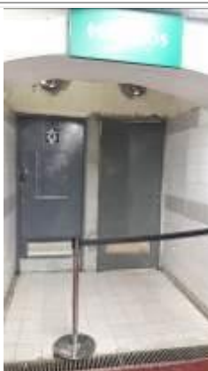
Foto N° 29 Línea D – Est. Catedral Sanitarios cerrados
