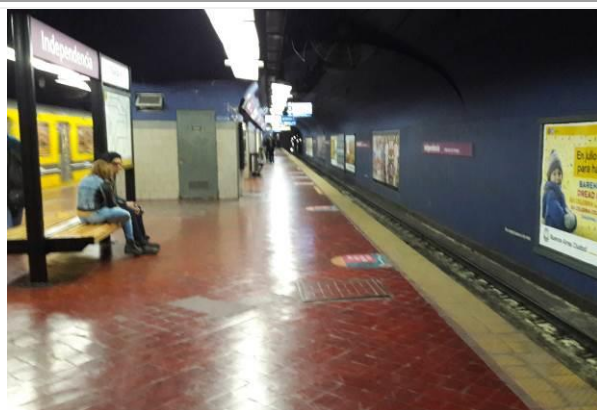
Foto N° 105 Línea E – Est. Independencia Sobre andén no posee señalización horizontal para no videntes
