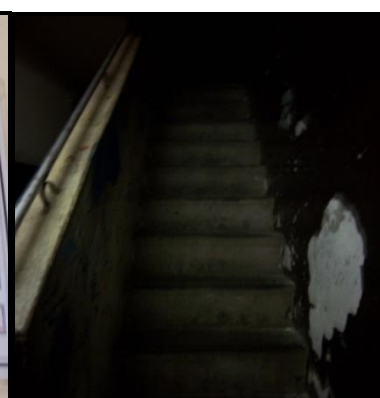
Escalera tercer piso
