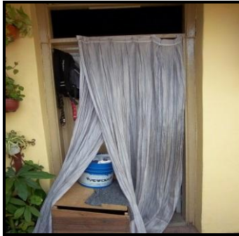
Falta de ventilación
