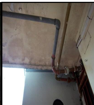
Instalación cañería agua
