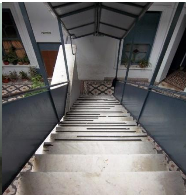
Escalera primer piso
