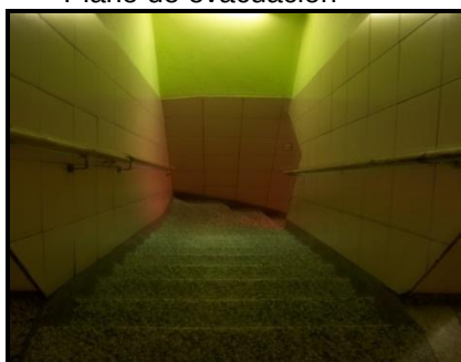
Escalera primer piso
