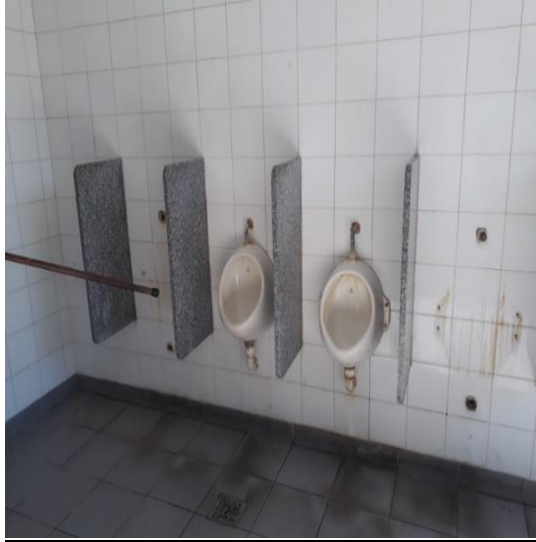
Foto 10: Baños Planta Baja Pabellón 1
