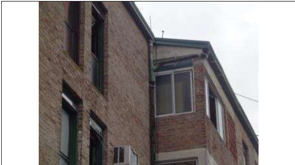
Pluviales rotos sobre la fachada. Ampliación en las expansiones
