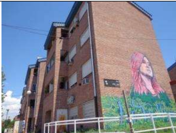
Vista del Barrio / Muros exteriores de ladrillo vista
