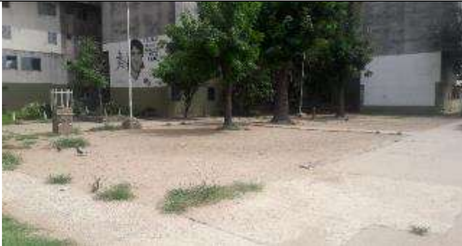
Falta de mantenimiento en espacio público.
