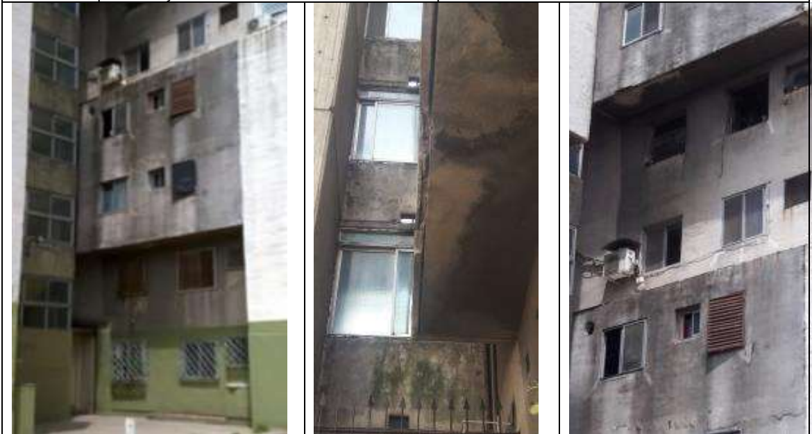
Fisuras y grietas, desprendimiento de revocos y manchas de humedad, corrosión en marcos y hojas de carpintería. Celosías desprendidas y modificaciones de ventanas realizadas por los habitantes.
