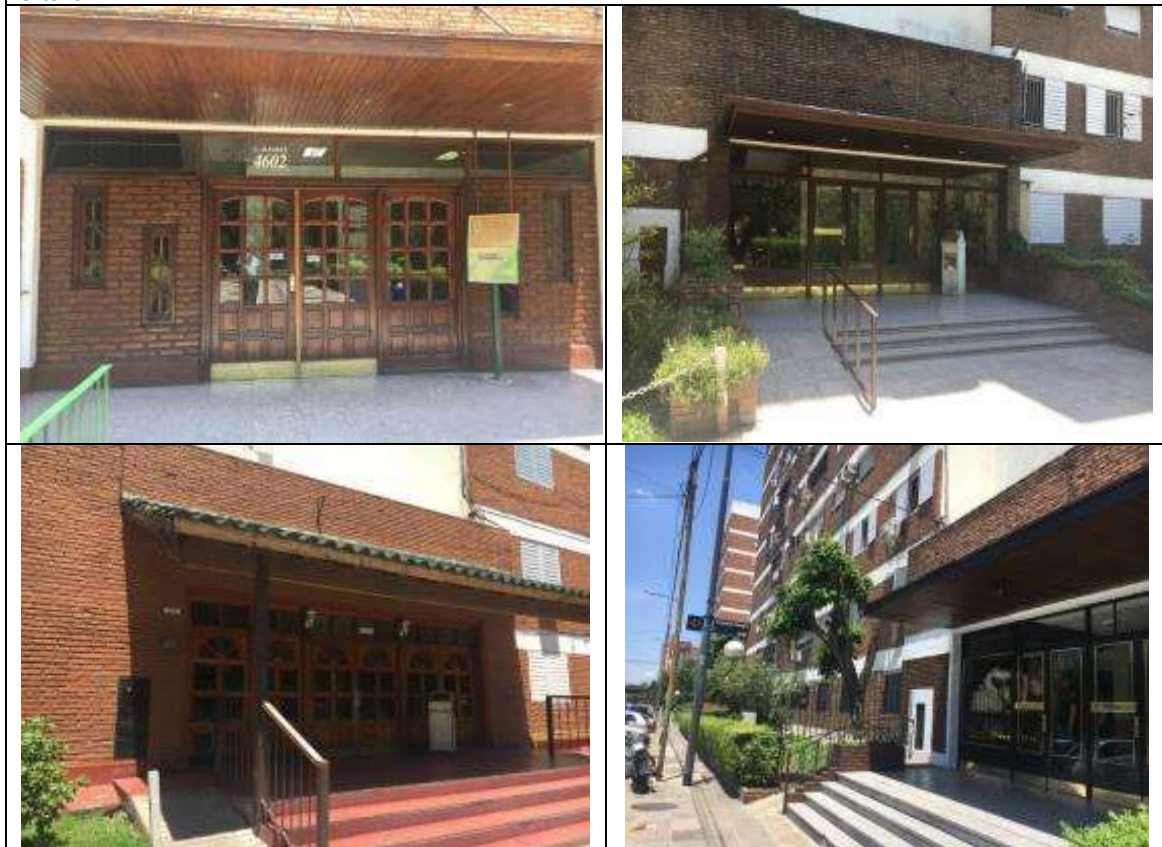
Se verificó buen estado de accesos a edificios, rampas y portero electrico.
