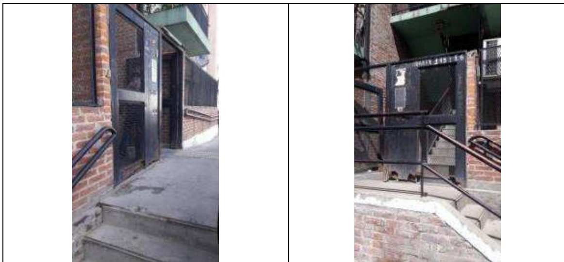
Acceso al edificio con puertas de chapa con considerable oxidación.
