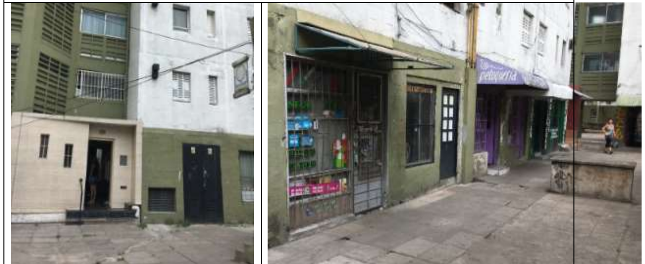
Readecuaciones realizadas por los habitantes de los edificios en acceso, aventanamientos y pasillos
