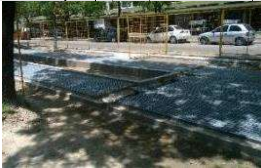
Asimismo se verificaron nuevas obras en veredas
