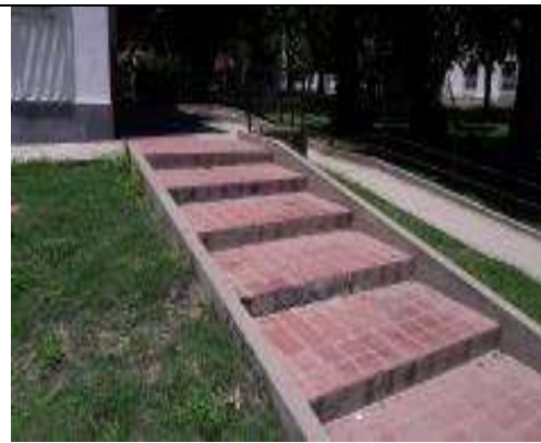
Escaleras y Rampas (nuevas)
