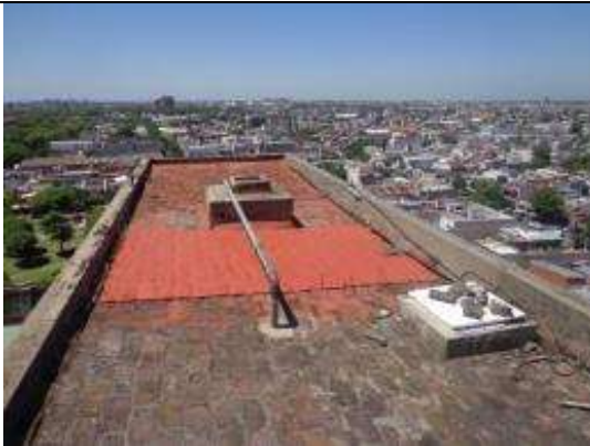
Tapas de inspección en tanques de agua Torre 1, clausurados y riesgo de caída.
