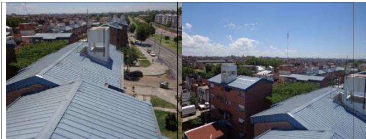
Vista de los techos
