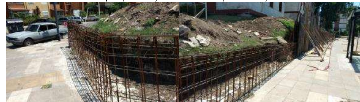
Se verificó en un sector de predio la ejecución de un muro de contención.
