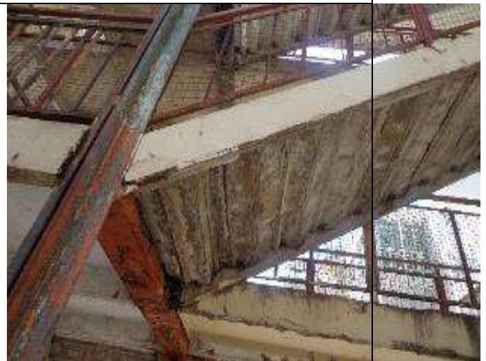
Barandas de contención con fallas de amure, desprendimiento de revoque de hormigón en escaleras y pasillos dejando fierros a la vista.
