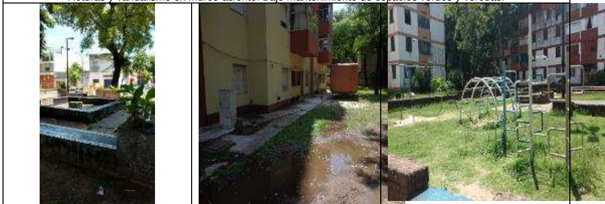
Inundación de espacio público. Bajo mantenimiento de espacios verdes y veredas
