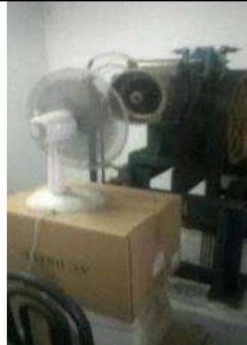
Ventilación del motor de ascensores Torre 1 ( 22 pisos) GS 3.
