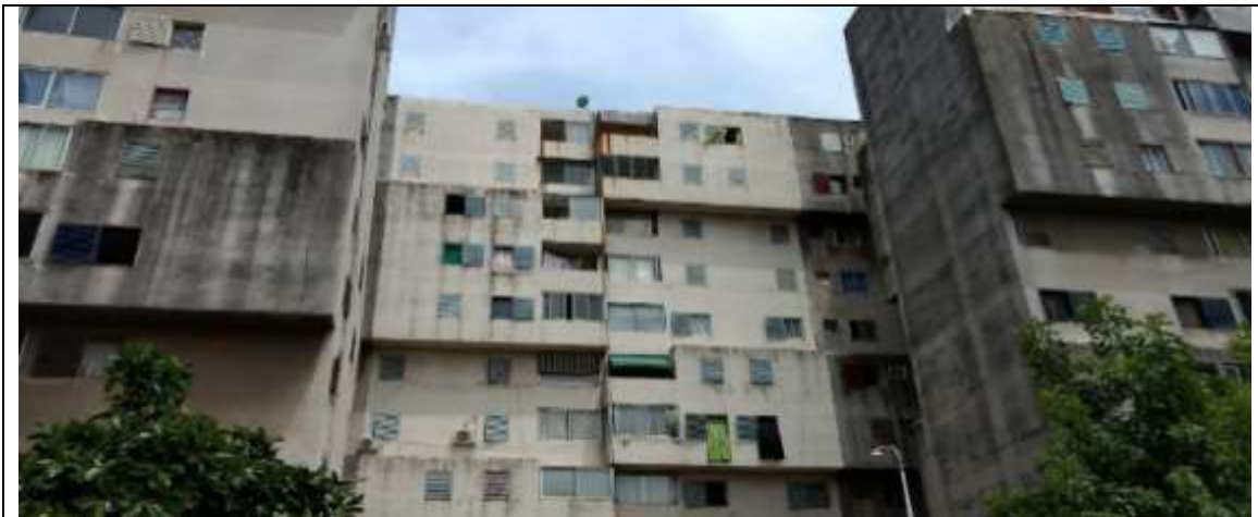
Fisuras y grietas, desprendimiento de revocos y manchas de humedad, corrosión en marcos y hojas de carpintería. Celosías desprendidas y modificaciones de ventanas realizadas por los habitantes.
