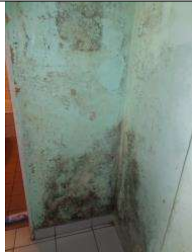
En interior de vivienda considerables filtraciones ocasionando humedad en paredes y cielorrasos.
