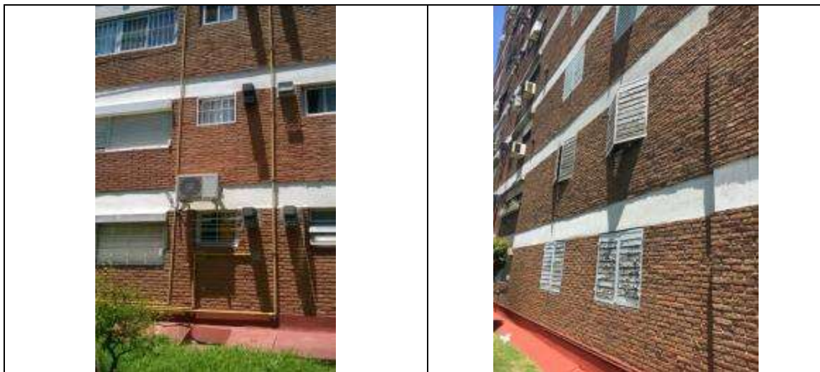
Algunos aventanamientos se encuentran con celosías originales y otros fueron remplazados por sistema de persianas exterior.
