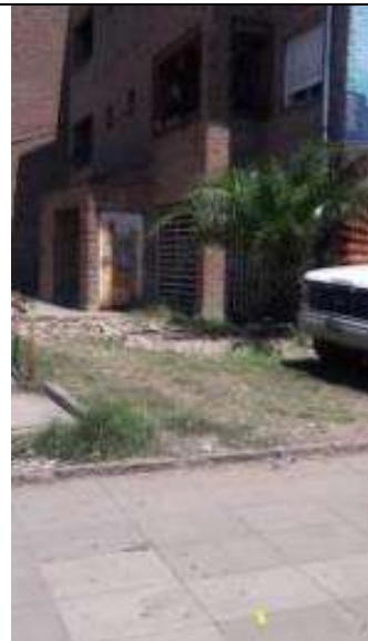
Se observan escombros sobre fachada.
