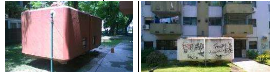
Los tanques de bombeo se encuentran en el área verde común a los edificios.
