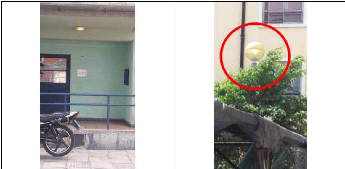
Luminarias encendidas durante la mañana del recorrido
