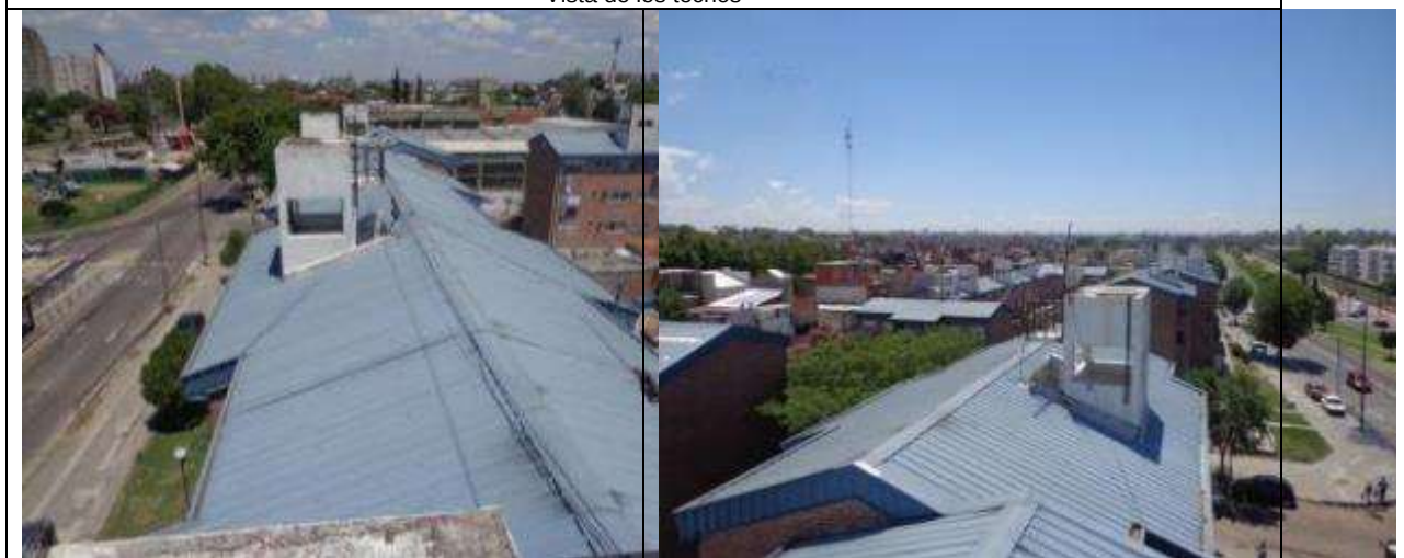
Vista de techos
