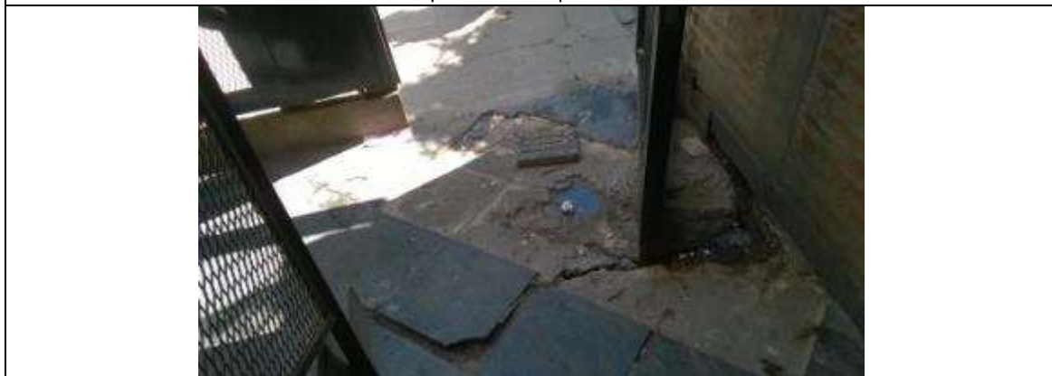
Acceso al edificio con puertas de chapa con considerable oxidación.
