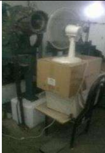
Ventilación del motor de ascensores Torre 1 ( 22 pisos) GS 3.
