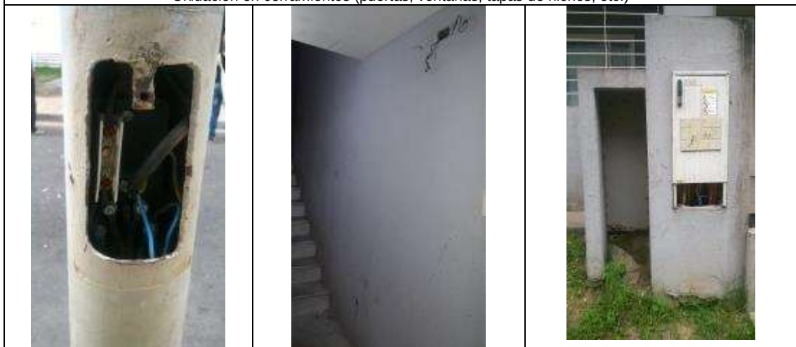
Cables expuestos.
