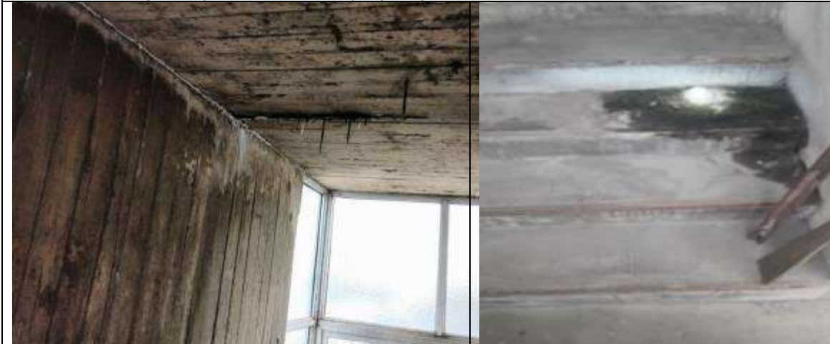
Filtraciones en losa por fisura de tanque
