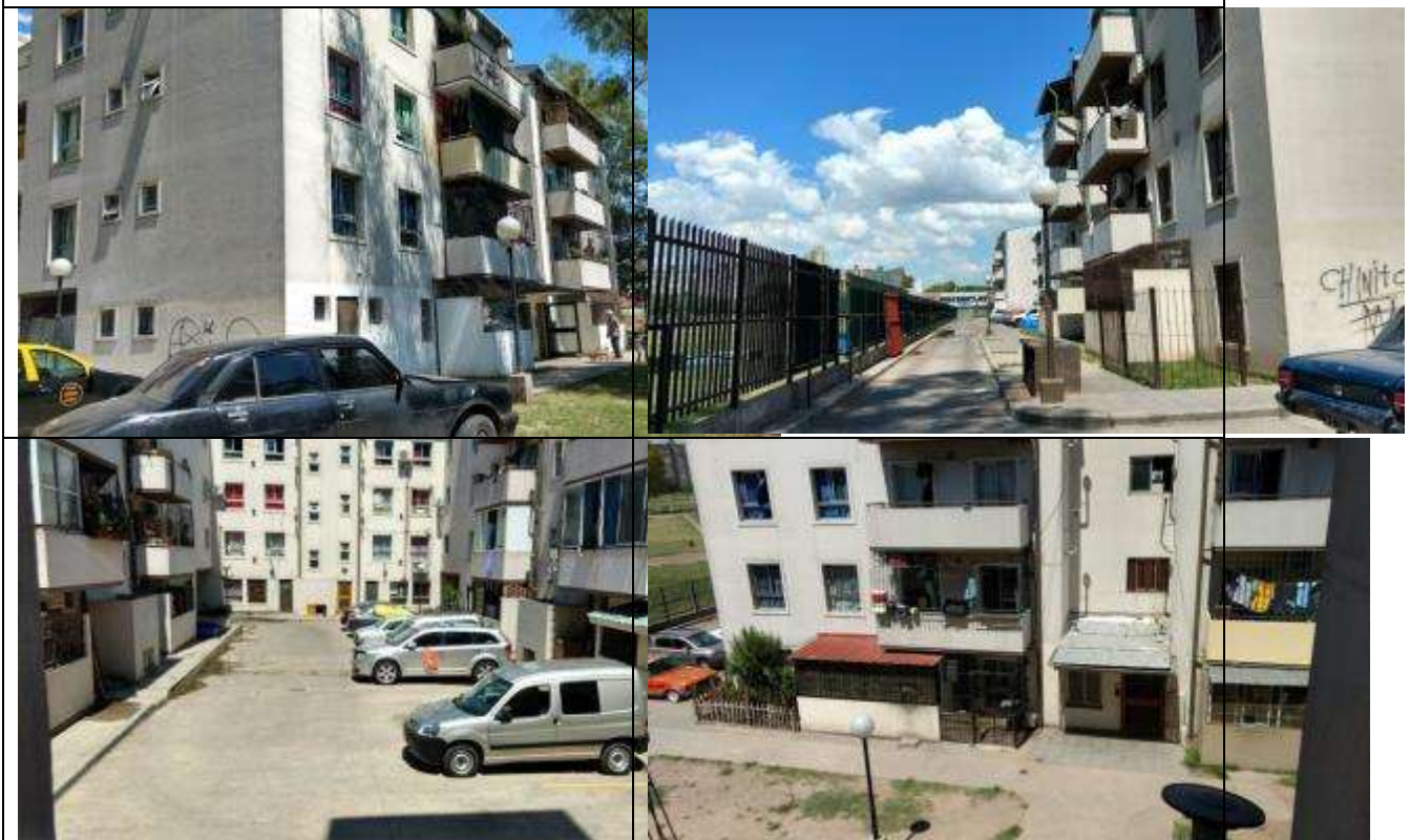
Muros exteriores buenos, pintura regular.
