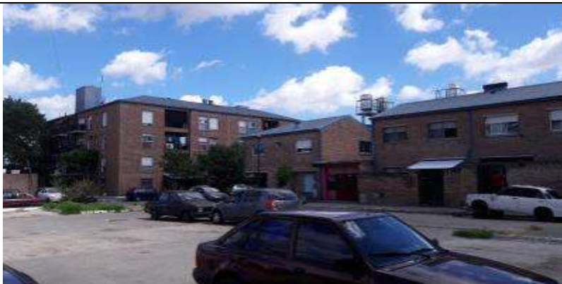
Se detectó la apropiación de espacios comunes exteriores para locales comerciales y viviendas.
