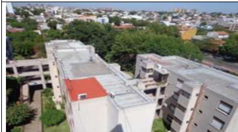
Adecuado mantenimiento de cubiertas con pintura asfáltica.
