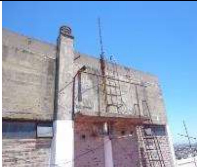
Tapas de inspección en tanques de agua Torre 1, clausurados y riesgo de caída.
