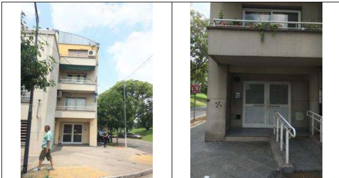
Accesos a los edificios en buen estado y con rampas para personas con capacidad reducida.
