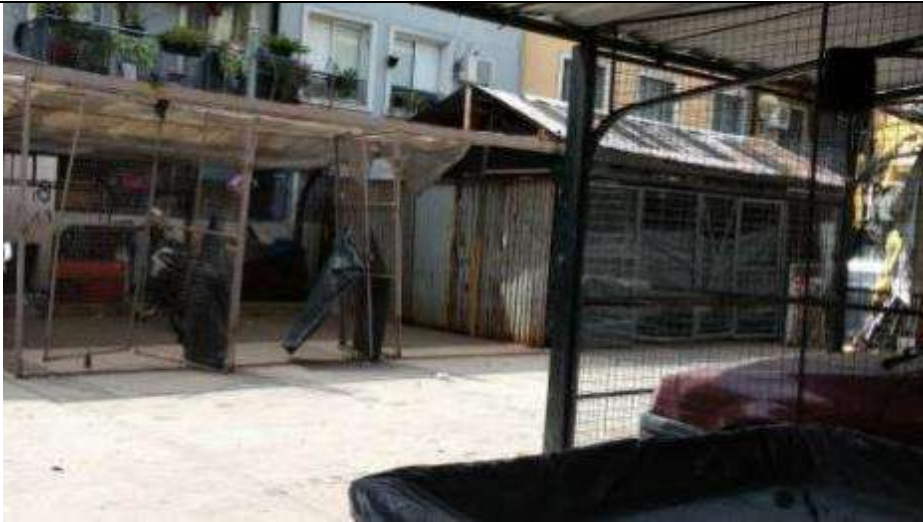
Se intrusan espacios comunes externos para ampliacion de viviendas, cocheras y/o utilizacion comercial.
