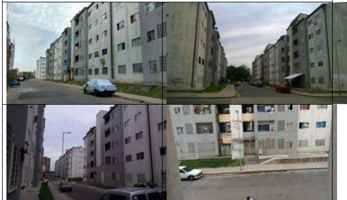
Mala terminación de revestimientos
