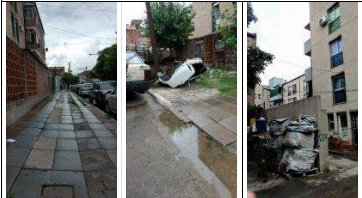
Veredas peatonales en mal estado. Inundación cordón cuneta por falta de limpieza de desagües. Restos de autos abandonados en el espacio público.
