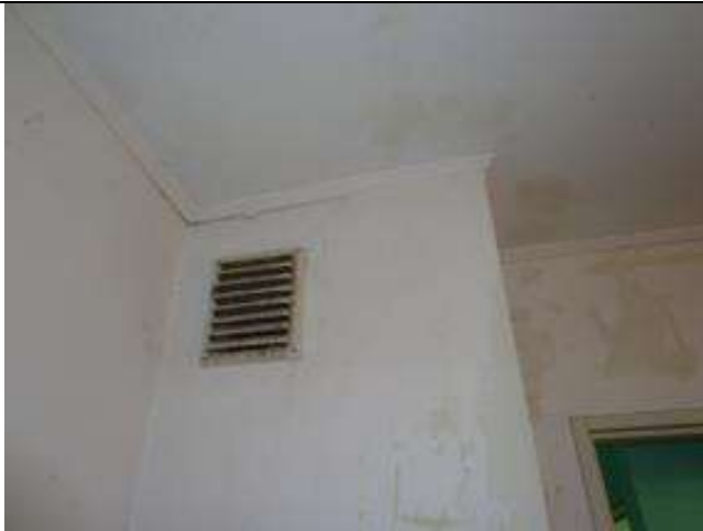
En interior de vivienda considerables filtraciones ocasionando humedad en paredes y cielorrasos.
