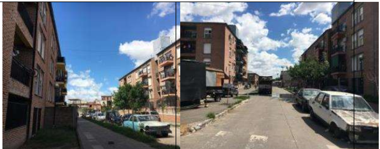
Muros exteriores de ladrillo a la vista. .
