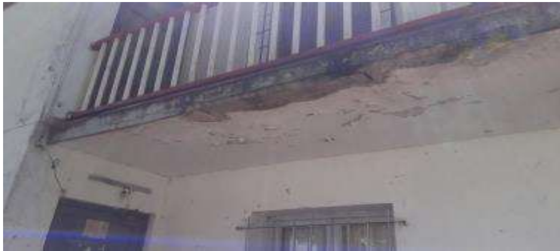
Balcones: Desprendimiento del recubrimiento en las losas. Barandas de madera con ausencia de mantenimiento.
