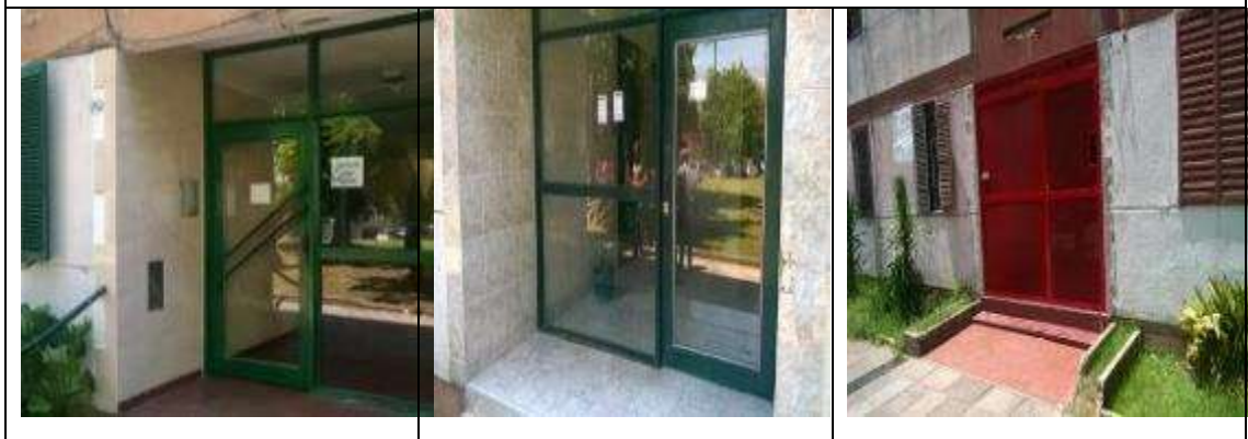
Los accesos a los edificios han recibido modificaciones de tipo estético, mediante revestimientos con cerámicos y en otros se han con cerramientos de malla metálica.
