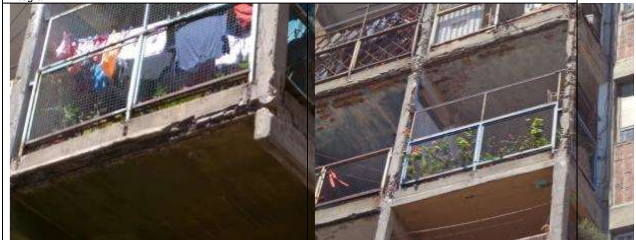
Paneles de ladrillos colapsados superficialmente a causa de la oxidación interna de las partes metálicas que lo integran.
