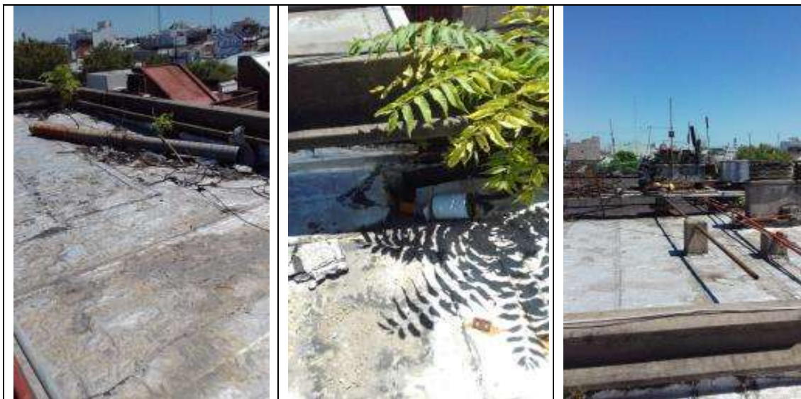
Azoteas: Originalmente revestida en ladrillo. En algunos sectores cubierta con membrana.
