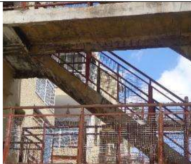
Barandas de contención con fallas de amure, desprendimiento de revoque de hormigón en escaleras y pasillos dejando fierros a la vista.
