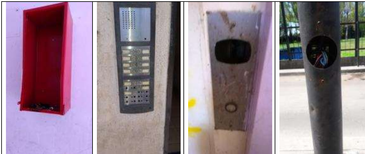
Vandalismo en matafuegos - Regular estado de portero eléctrico – Vandalismo en el boton llamador de ascensor (aunque el mismo no esta instalado) - Cables expuestos en postes de luz.
