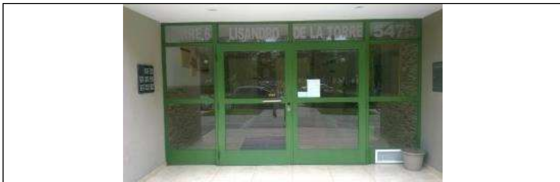
Acceso con carpinterías de chapa doblada.
