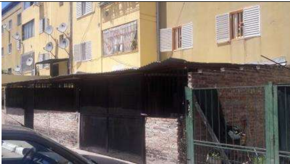
En planta baja ocupación de espacios comunes con cerramientos de ladrillo y techo de chapa.
