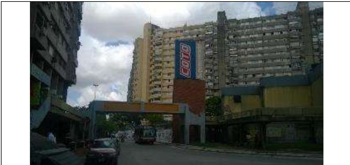
Este es el caso de una intervención verificable del IVC en la reconstrucción de un puente de hormigón armado
