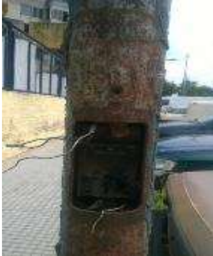
Vandalismo en columna de alumbrado público con cables a la vista. Solado en mal estado en accesos.
