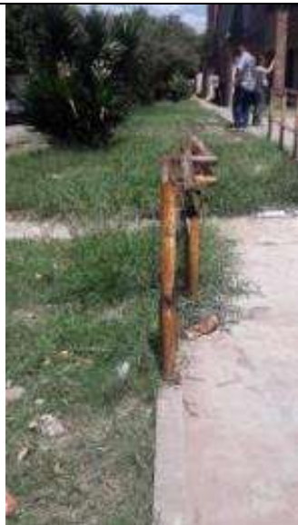
Rampas con difícil acceso por pastos crecidos. Barandas de rampas oxidadas
