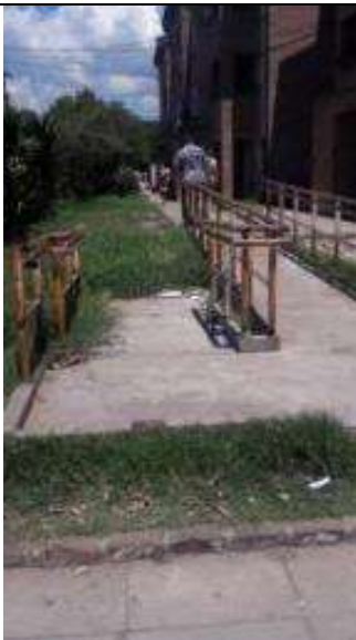
Rampas con difícil acceso por pastos crecidos. Barandas de rampas oxidadas
