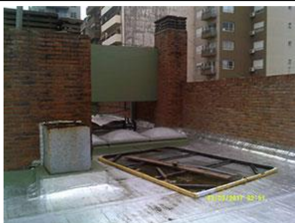
Cartel de obra y otros elementos depositados sobre la membrana, poniendo en riesgo su integridad.
