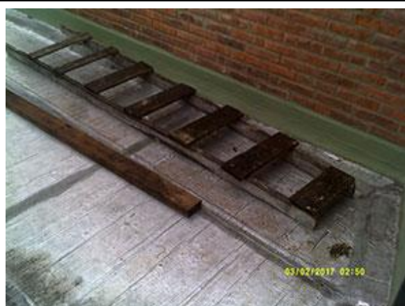
Cartel de obra y otros elementos depositados sobre la membrana, poniendo en riesgo su integridad.
