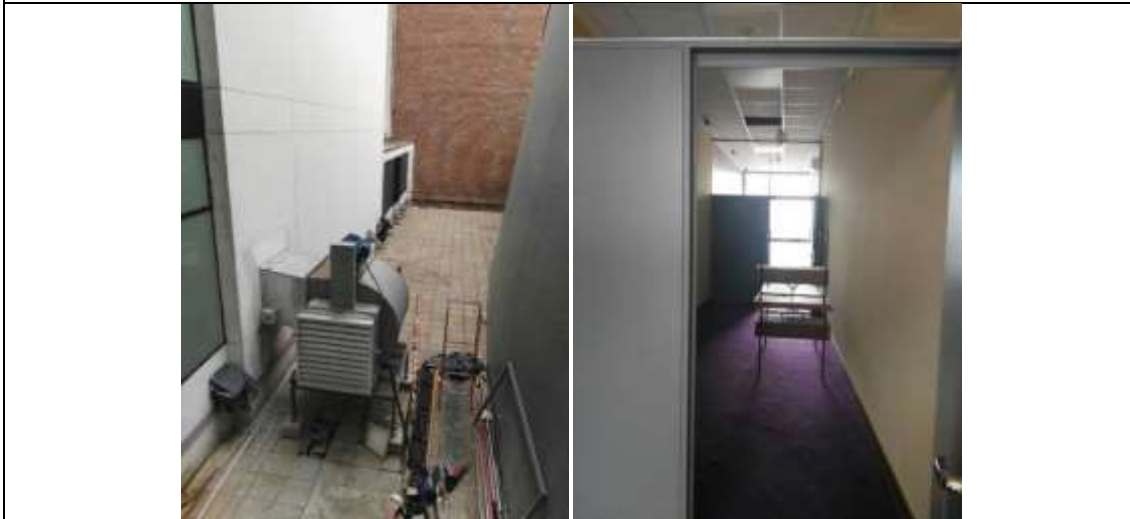
Fotos 23-24 Instalación de extracción de aire y oficinas.
