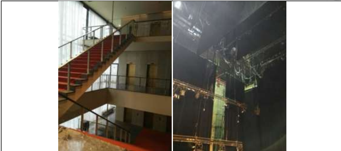
Fotos 21-22 Escaleras tapizadas a nuevo respetando los colores originales. Bambalinas con telón corta fuego y sistema de evacuación de humo cenital e instalación de rociador en altura con sistema seco.
