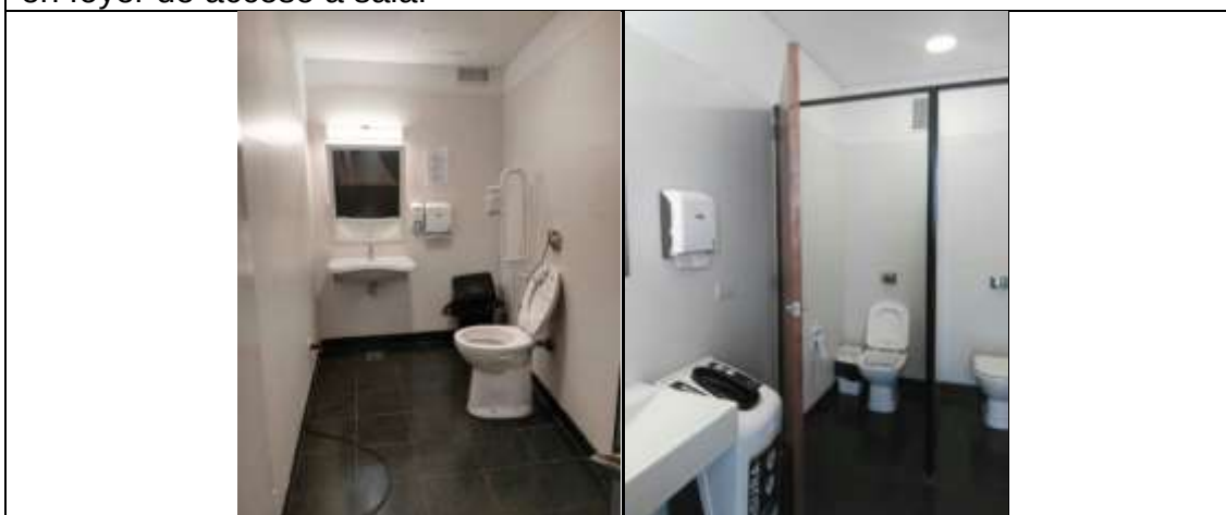
Fotos 10-11 Instalación de baños para discapacitados, cumple Ley N° 962 de accesibilidad, en todos los pisos y sanitarios.
