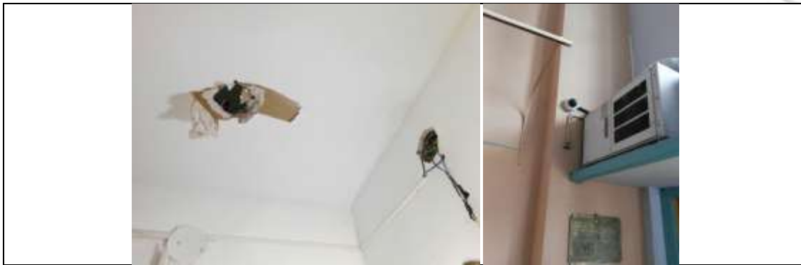
Fotos 10-11 Circuito cerrado de cámaras de seguridad y detectores de humo en correcto estado de mantenimiento.
