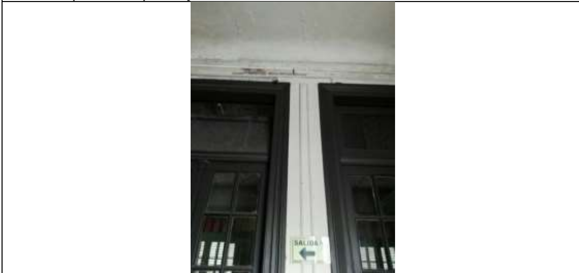
Fotos 10 Señalética deficiente
