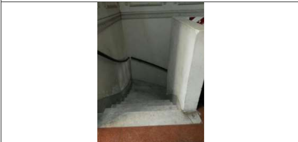
Fotos 11 Ausencia de cintas reflectantes y antideslizantes en pedadas
