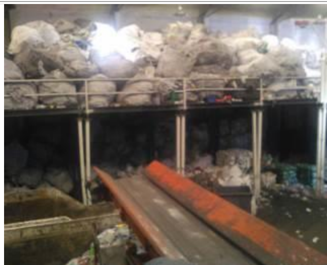
Foto N° 48 Sobre entepiso importante carga de bolsones con material reciclable.
