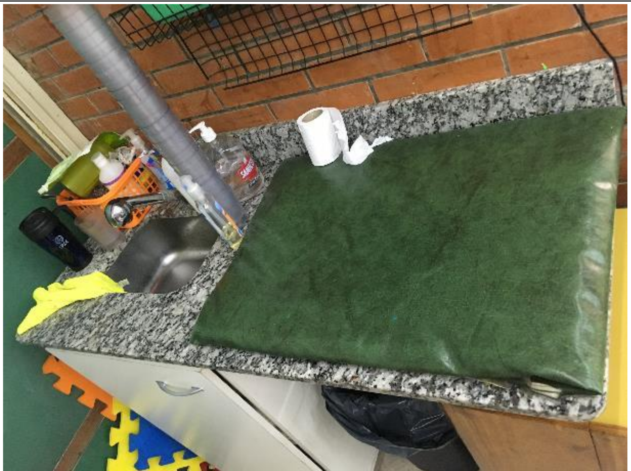
Bacha demasiado pequeña para el uso requerido. Grifería de mala calidad, funciona parcialmente.
