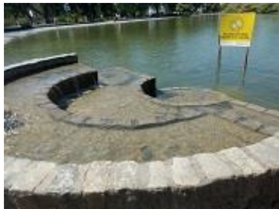
Vista del lago y aireadores. Cascada de oxigenación y alimentación de agua
