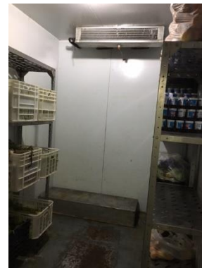
Interiores de camaras en buenas condiciones
