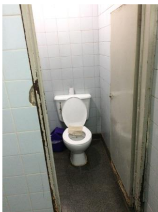
Baño personal en regulares condiciones
