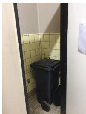
Depósito de residuos
