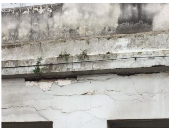
Reparación en exteriores Para evitar ingreso de humedad
