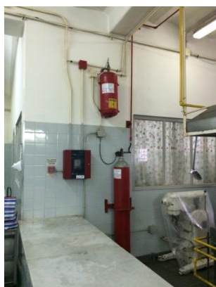
Sistema de extinción en campana
