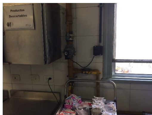
Corte automático de gas
