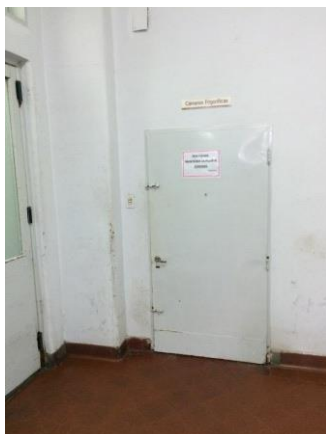
Acceso a cámaras
