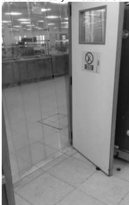
Nivel de Cocinas y Líneas de Servicio
