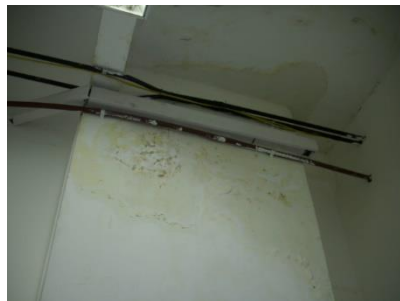
Paredes con problemas de humedad (Observación 17.5).
