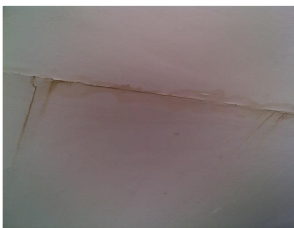
Filtraciones en sectores impermeabilizados.
