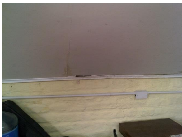
Filtraciones en sectores impermeabilizados.
