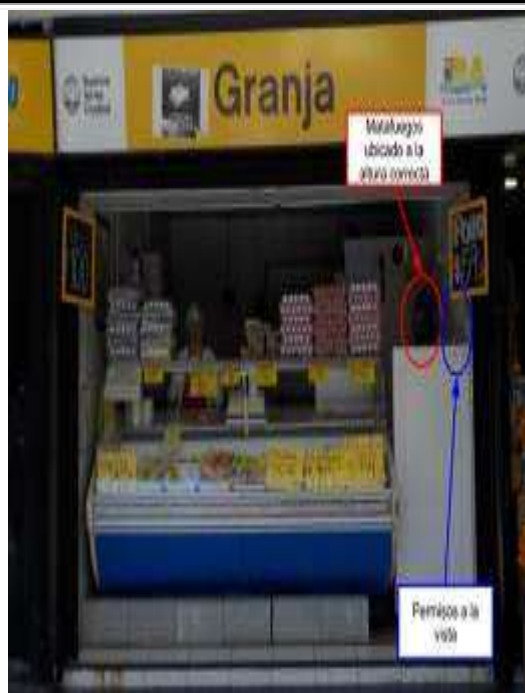
Foto N° 102 - Local 10. Granja, sobre la calle Rojas.
