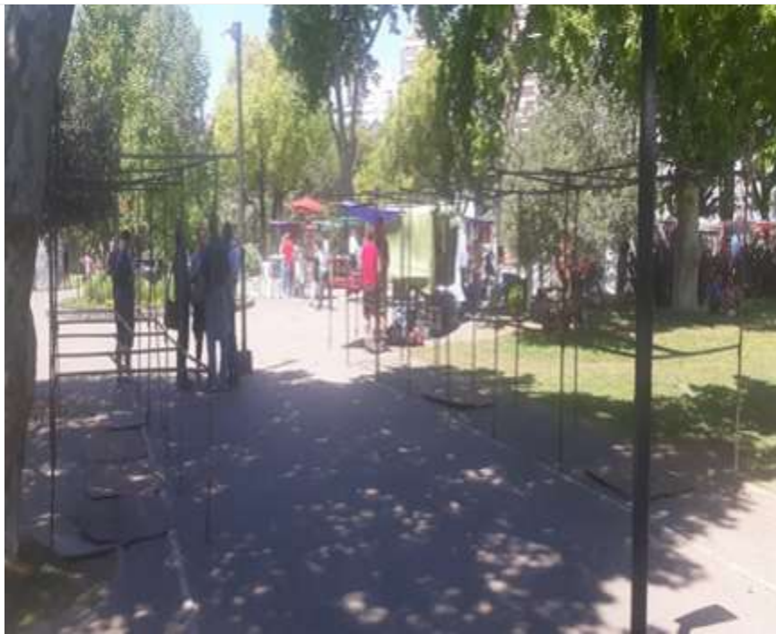
Foto N° 20 Puestos vacíos, la falta de pintura (oxidados) en las estructuras.
