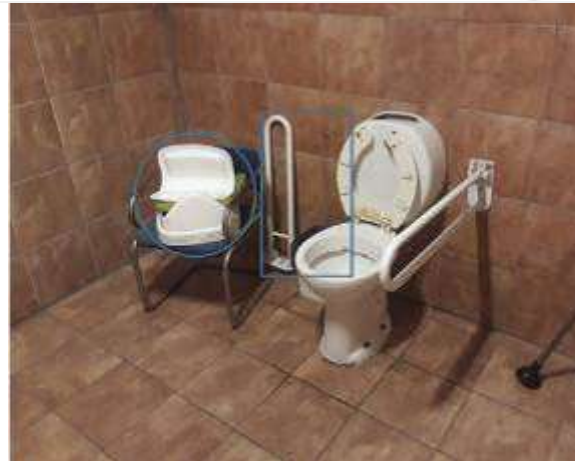
Foto N° 85 - Interior Baño para Discapacitados. Varios elementos fuera de lugar / sueltos.
