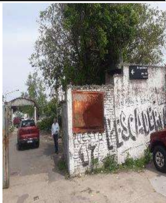
Foto N° 120 - Portón de entrada de vehículos por calle Enrique Ochoa
