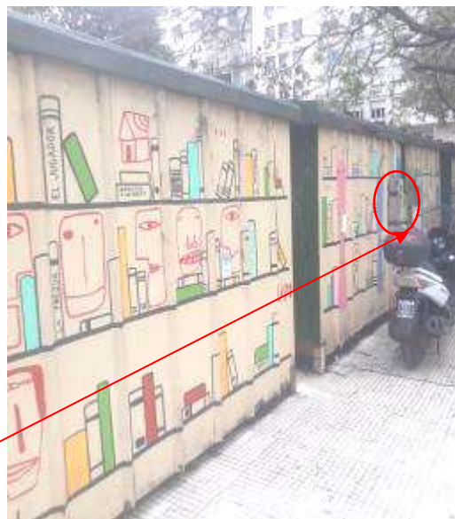
Foto N° 38 - base reparada de puesto con oxido.
