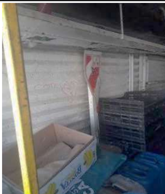
Foto N° 73 - falta de extintor
