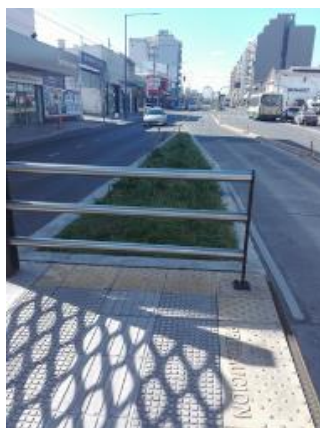
Parador con una rampa en uno de sus extremos y baranda con puntera verde en el otro. Ancho de rampa: 1.00mts
