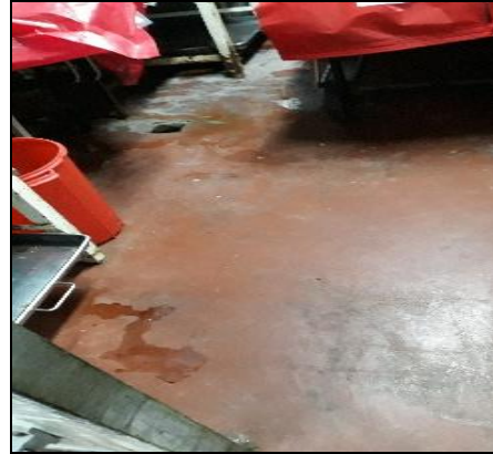
Cámara y antecámara(obs.11)
