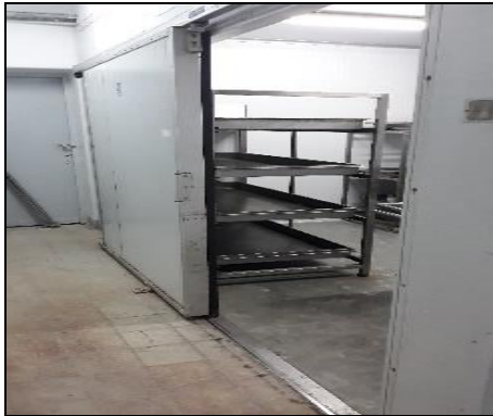
Acceso a Cámara(obs.11)
