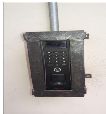
Control de acceso biométrico / No operativo (obs.7)
