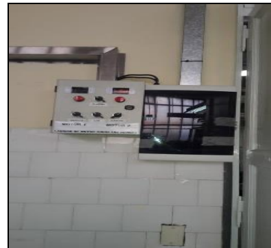
Control digital de temperatura (obs.11)
