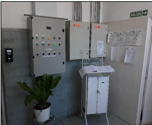
Nueva Instalación eléctrica(obs.34)
