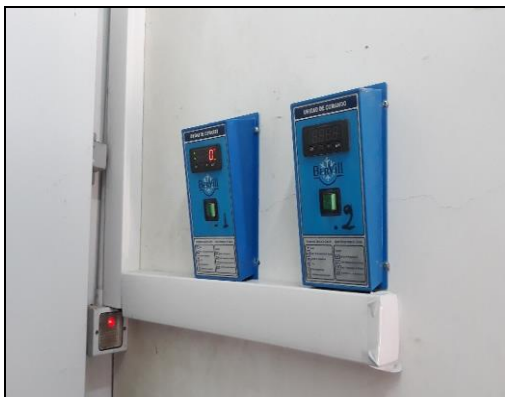
Control Digital de temperatura(obs.11)
