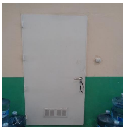
Local asignado para el depósito exclusivo de residuos bio sanitario en el depósito general
