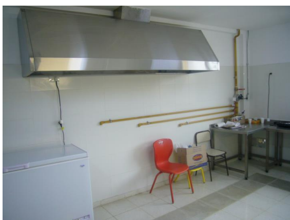
Vista de la cocina con baldosas antideslizantes y la falta de conexión de red de gas
