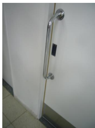
Falta señalética conforme pliego. El herraje de cierre no es reglamentario. En ambos baños, es de cerrojo con llave y no permite su apertura exterior en caso de emergencia.
