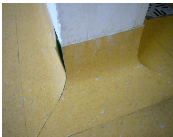
Ejemplos de fallas encontradas en la totalidad de los pisos de goma en la construcción (fotos 1,2,3 y 4).
