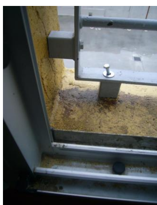
Incorrecto anclaje mecánico de las rejas. Previsión de seguridad en equipos aplicados en altura
