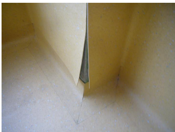
Revestimiento vertical y próximo al zócalo despegado y sin sellado de encuentro.
