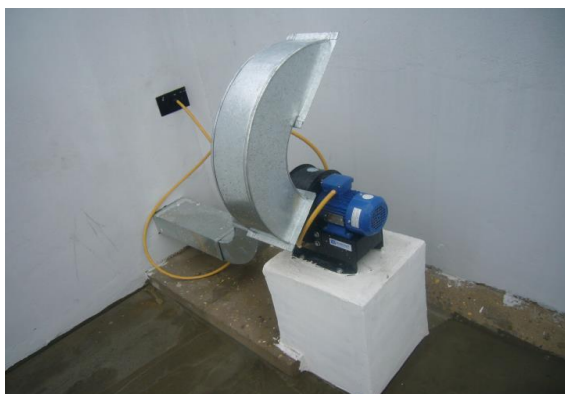
Conexión al aire libre del recirculador en terraza sin la protección por brida de sujeción.
