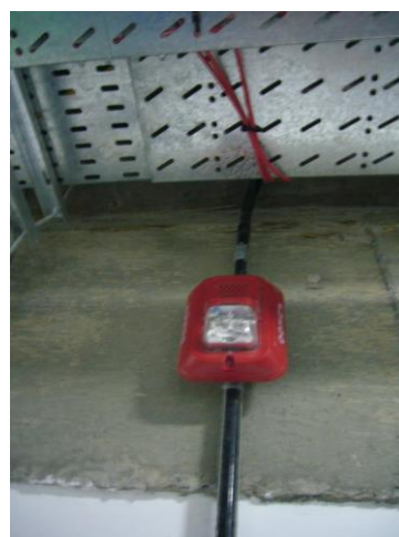
Llave de paso y alarma de incendio. Sirena con indicador lumínico.
