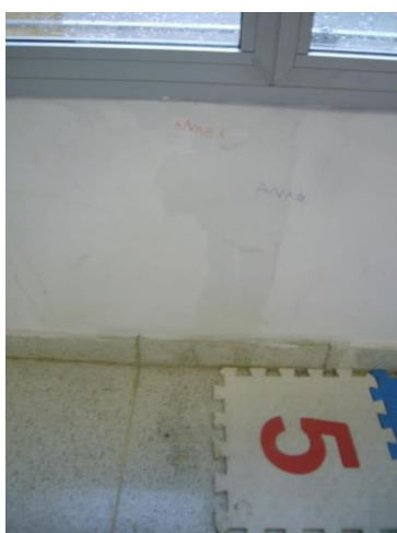
Ejemplo de filtraciones en el encuentro de carpintería y mampostería.
