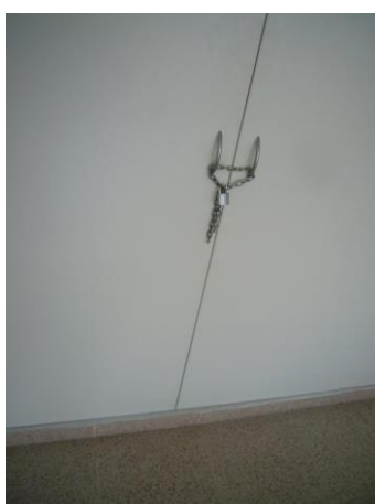
Imprevisión de herraje de cierre mecánica
