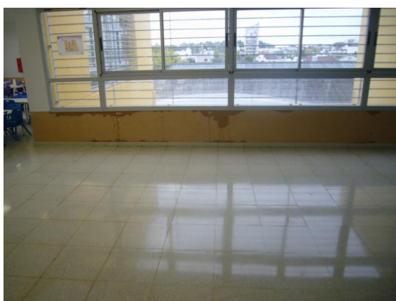
Ejemplos de chorreadura en varios locales del edificio entre carpintería y muro
