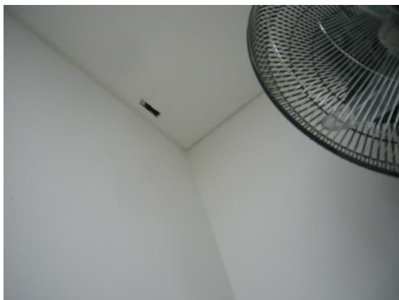
Detalle de terminación en cielorraso.
