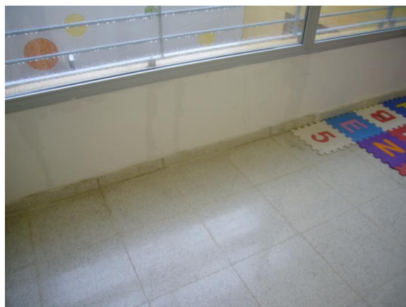
Ejemplo de filtraciones en el encuentro de carpintería y mampostería.
