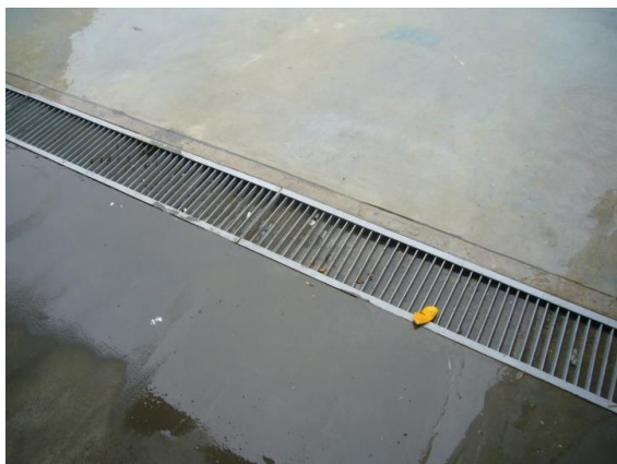
La canaleta de desagüe carece de profundidad en el primer tramo. Juegos en planta baja (patio)
