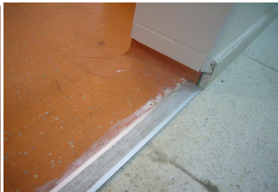
Existen diferencias de niveles de solados que no fueron salvadas en las modificaciones del proyecto original.
