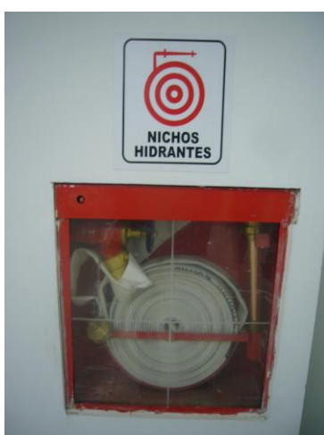
Nicho hidrante del sistema
