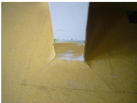
Los zócalos de goma se encuentran despegados y no han sido selladas sus uniones.
