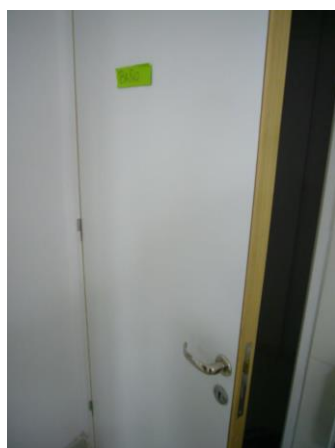
Falta señalética conforme pliego. El herraje de cierre no es reglamentario. En ambos baños, es de cerrojo con llave y no permite su apertura exterior en caso de emergencia.
