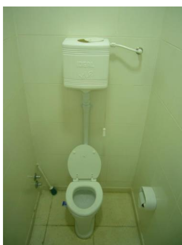
Se repite en varios casos la perdida en los depósitos sanitarios.
