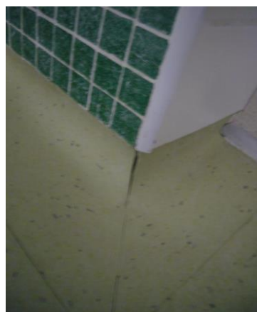
Ejemplos de encuentro de solados en diferente nivel. Deberían estar en un mismo nivel.
