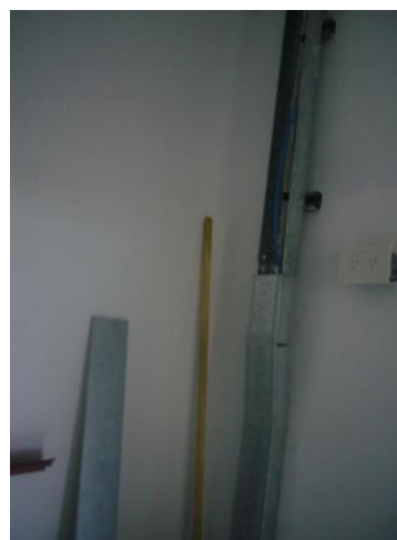
Montacarga. Imprevisión de tomas para comunicador y falta colocar tapa en montante.
