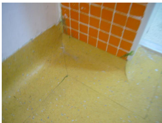
Revestimiento vertical y próximo al zócalo despegado y sin sellado de encuentro.
