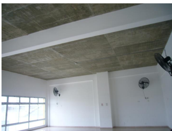
Cielo raso de hormigón visto sin tratamiento acústico. Sensor de movimiento
