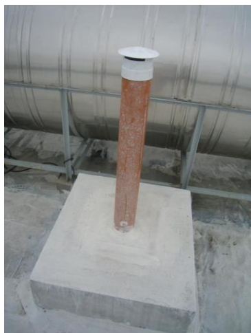
Caño sin protección UV. Alambres oxidados que afectarán al acero de los tanques por contacto.
