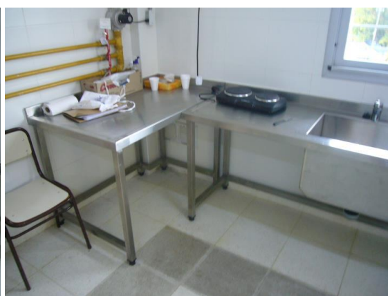
Vista de la cocina con baldosas antideslizantes y la falta de conexión de red de gas
