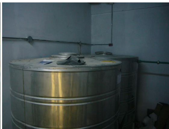
Acumulación de materiales sobrantes de obra. Falta de higiene sanitaria en depósito de agua.
