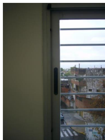
Parante horizontal vencido impide apertura de hojas. Ventana con mecanismo de cierre trabado
