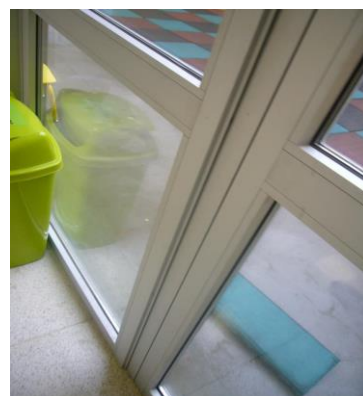
Ejemplo de plano de evacuación. Ausencia de herrajes (puertas trabadas con tachos de basura)
