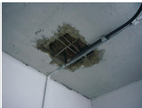
Cierre de losa de techo pendiente.
