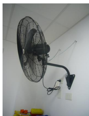
Incorrecto anclaje mecánico de las rejas. Previsión de seguridad en equipos aplicados en altura
