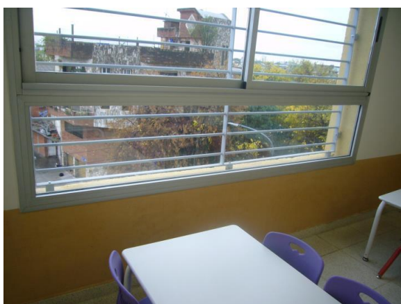
Parante horizontal vencido impide apertura de hojas. Ventana con mecanismo de cierre trabado
