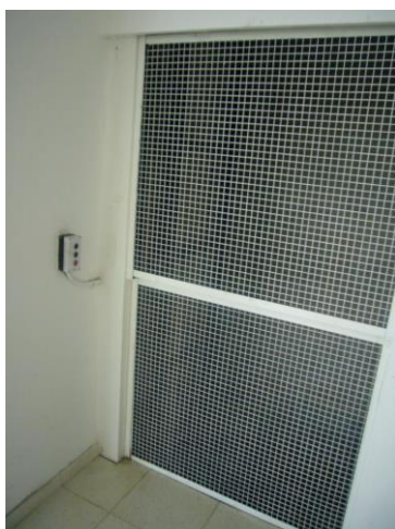
Montacarga. Imprevisión de tomas para comunicador y falta colocar tapa en montante.
