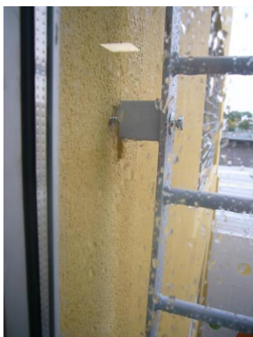
Ejemplo de rejas con fallas en su fijación por ausencia de tornillos o falta de ajuste
