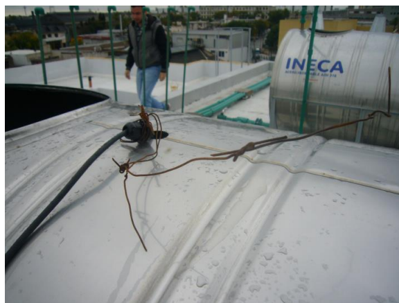
Caño sin protección UV. Alambres oxidados que afectarán al acero de los tanques por contacto.
