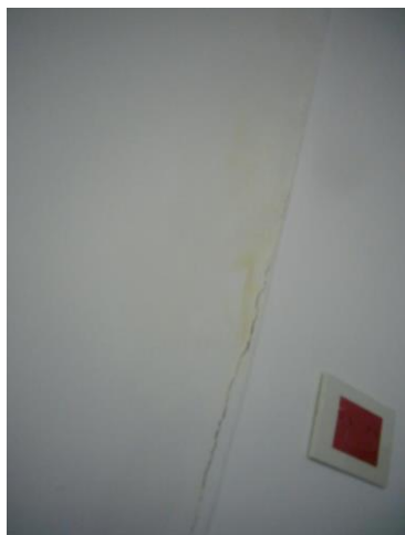
Fisuras y filtraciones en medianera
