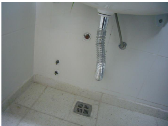
Falta de conexión de agua caliente y volantes y campanas
