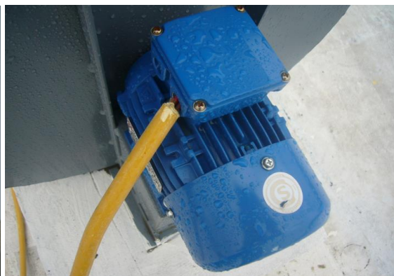
Conexión al aire libre del recirculador en terraza sin la protección por brida de sujeción.
