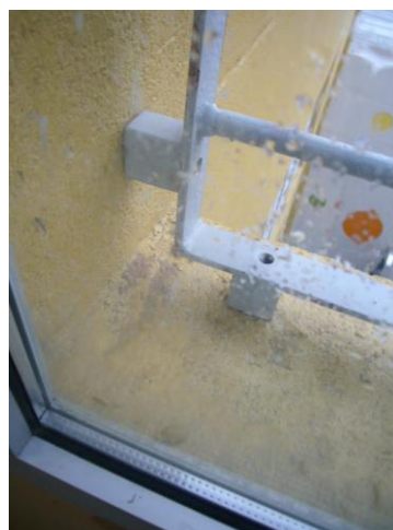
Ejemplo de rejas con fallas en su fijación por ausencia de tornillos o falta de ajuste
