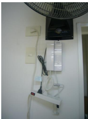
Montacarga. Imprevisión de tomas para comunicador y falta colocar tapa en montante.
