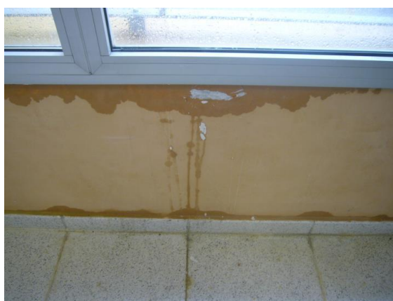
Ejemplos de chorreadura en varios locales del edificio entre carpintería y muro
