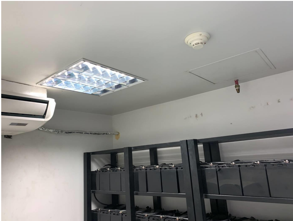
Detectores de humo y extinguidores en el techo.
