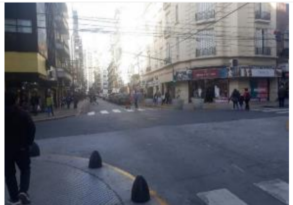
Foto N°2- PLAN ONCE Etapa 4 Esquina Sarmiento y Castelli cableado aéreo (falta soterramiento de cable aéreo) cestos de residuos bulbos Cuentan con vados peatonales Bolardos (tipo bala) de hierro
