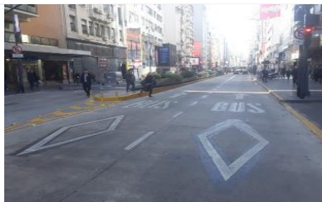
Foto N°11- Corrientes Cultural - Etapa 2 Corrientes 1774 Cantero central , Pintura en cordones Señalética vial Tachas Dársena Elevamiento de calzada
