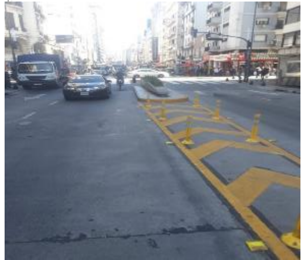
Foto N°14- Corrientes Cultural - Etapa 2 Corrientes 1180 Delineador rebatibles vial de 80 cm filtro UV reflectivos Tachas finalización de canteros
