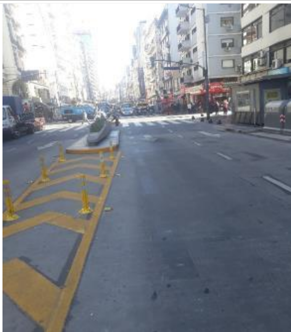
Foto N°15- Corrientes Cultural - Etapa 2 Dársena porta contenedores de residuos Bolardos Elevación en boca calle altura vereda
