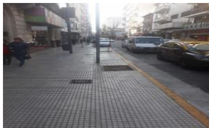
Foto N°3– PLAN ONCE Etapa 4 Sarmiento 2697 Falta de planta (arbolado) no repuesta Ensanche de vereda, dársena Cesto de residuos Pluviales
