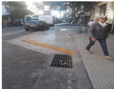
Foto N°7– PLAN ONCE Etapa 4 Perón 2577 Ensanche de vereda Soterrado de contenedores de Residuos Alcantarillas Rejilla de desagüé pluvial Dársena descarga demarcación horizontal para dársenas existentes Rejillas nuevas.
