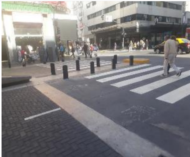
Foto N°13- Corrientes Cultural - Etapa 2 Rodríguez Peña y Corrientes Bolardos metálicos
