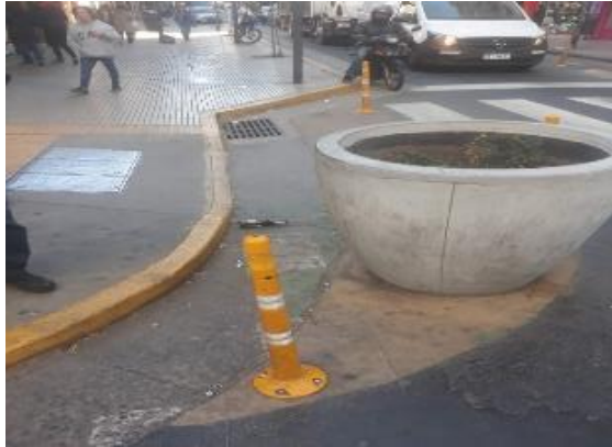
Foto N°5– PLAN ONCE Etapa 4 Castelli 102y B. Mitre Bulbos de veredas Maceteros sin planta Pluvial nuevo Vereda ensanchada Delineador rebatible vial
