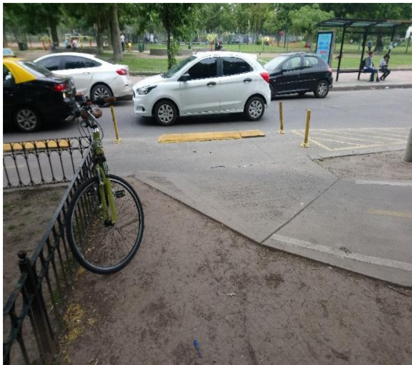
Giro de ciclovía y desnivel entre material y la tierra. Parque Centenario.
