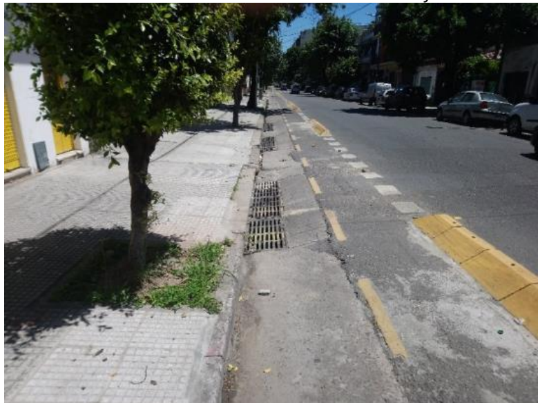
Sumideros y rampa de acceso a garaje sobre ciclovía. Artigas 1524
