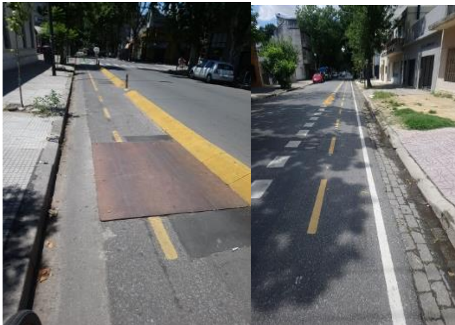
Plancha de acero sobre la vía y sobre parche. Gorriti 5825 Empedrado en un carril. Doblas 100.
