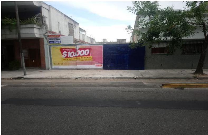
Figura 11. Se observa la falta de cordones retirados por obra en la ciclovía de la calle Artigas entre las intersecciones de Camarones y San Blas.
