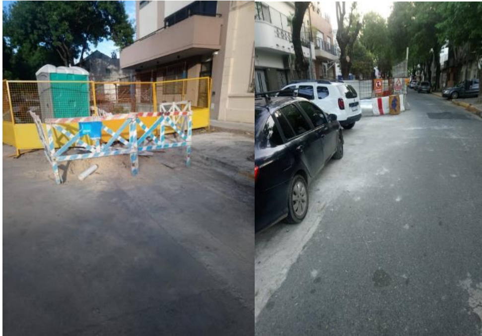
Figuras 5 y 6. Corresponden a las aberturas complementarias de la obra del Arroyo Vega, siendo las mismas pertenecientes a la calle Nueva York entre Helguera y Argerich (foto 5) y Nueva York entre Artigas y Zamudio (foto 6).
