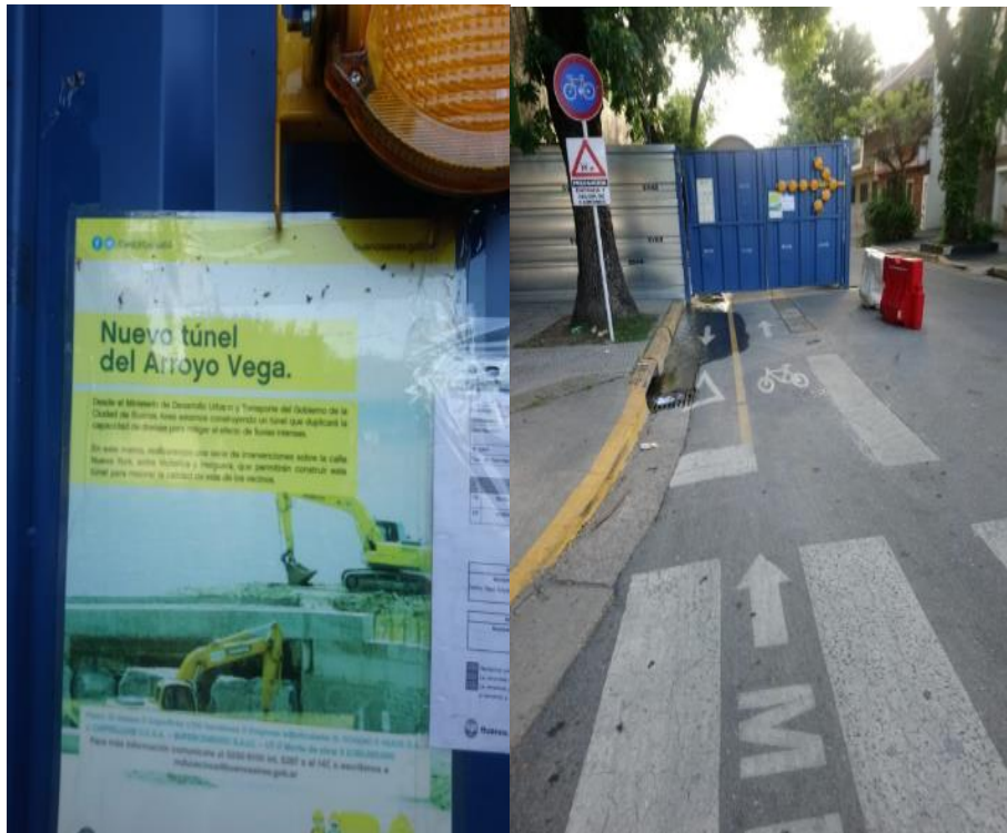
Figura 2 y 3. Cierre de la calle Nueva York entre las intersecciones de Terrada y Condarco por obrador del nuevo Túnel del Arroyo Vega. Aquí se levantó la totalidad de los elementos que componen la ciclovia poco tiempo después de su construcción en noviembre de 2017.
