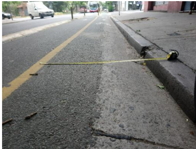
Aquí se puede observar la inclinación sobre la banda de rodamiento de uno de los carriles. Pavón 1473
