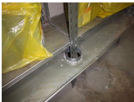
Bandeja antiderrame y depósito de acopio final de Residuos Líquidos Peligrosos
