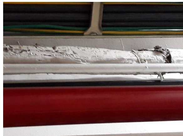
Asbestos desgranandose
