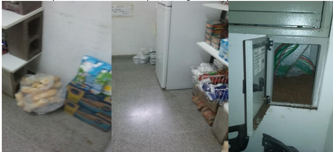
Alimentos acopiados directamente en el piso; hormiguero en tapa de acceso a tablero eléctrico:
