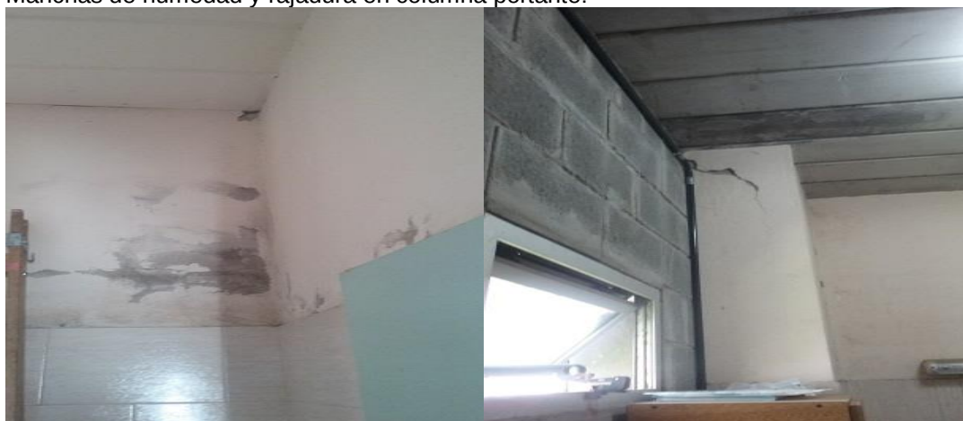
Manchas de humedad y rajadura en columna portante:
