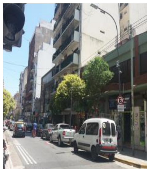
LP N° 1249/17 – calle J. D. Perón entre Larrea y Azcuénaga
