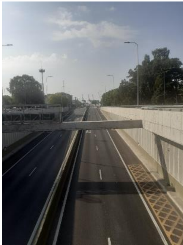
Foto/s N° 14 Vista empalme Tramo A, sentido Norte, altura aprox. Calle Cabo Pablo Felds
