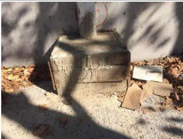
Foto/s N° 12: Av. Antártida Argentina. Se observa base de hormigón sin terminar (con el encofrado aún colocado).
