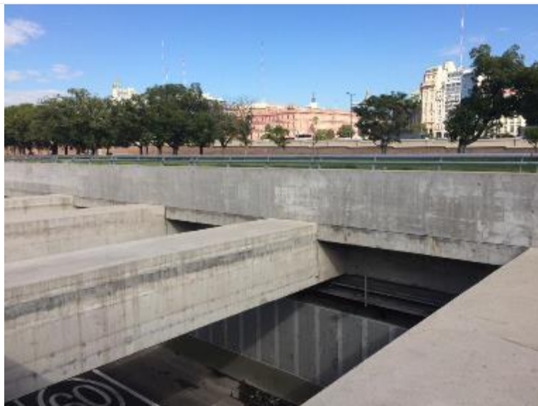
Foto/s Nº 1 Vista trinchera abierta en Empalme Tramo B – Bartolomé Mitre (aprox.)
