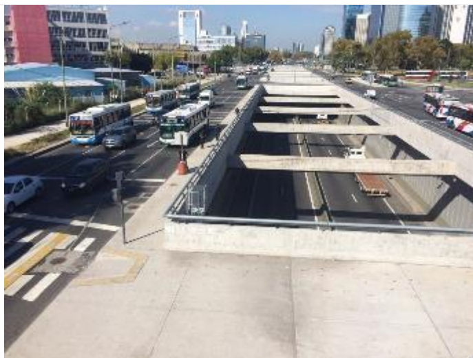
Foto/s N° 15: Vista trinchera abierta Altura Terminal de Ómnibus de Retiro
