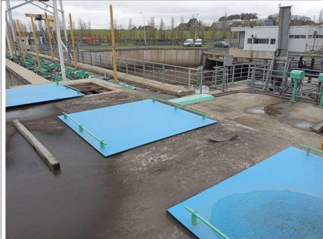
Bombas (2 de 290 Kw y 1 de 190 KW) Lado River.
