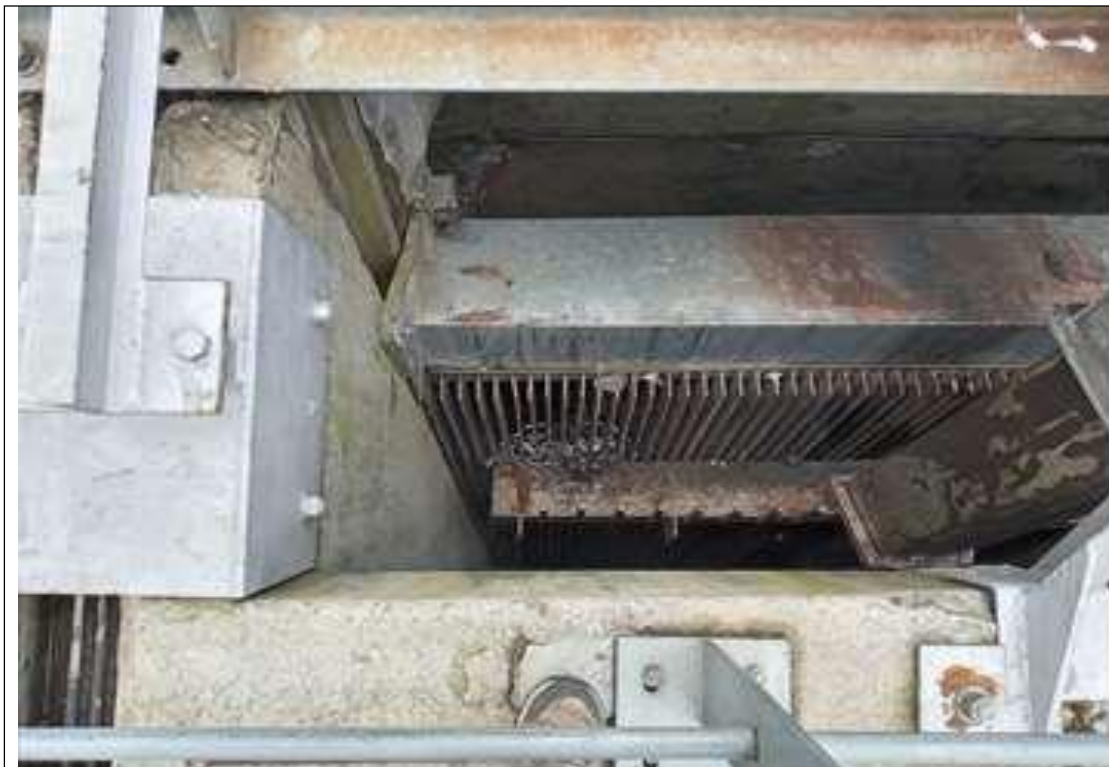
Sistema limpiarregas e hidrojet una vez limpia la compuerta.
