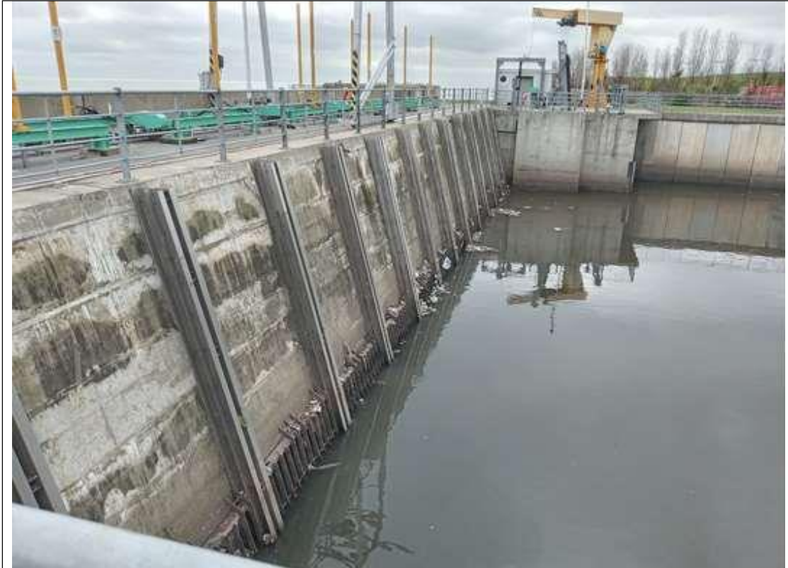
Presa de hormigón con trece conductos de descarga al Río de la Plata con rejas. Arriba, los trece mecanismos de apertura de las compuertas (color verde).
