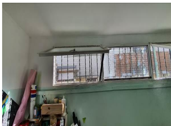
Foto 44 sistemas caseros para la apertura de ventana en aula de atrás.
