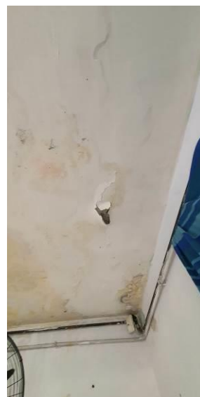
Foto 70 Humedad en pasillo a las aulas. Foto 71 Humedad en aula 1 Foto 72 Humedad en aula 1
