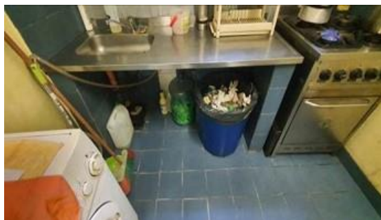
Foto 85 Mesada de cocina con pileta sin mueble bajo mesada
