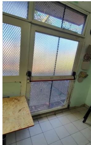
Foto 33 Puerta salida de emergencia.
