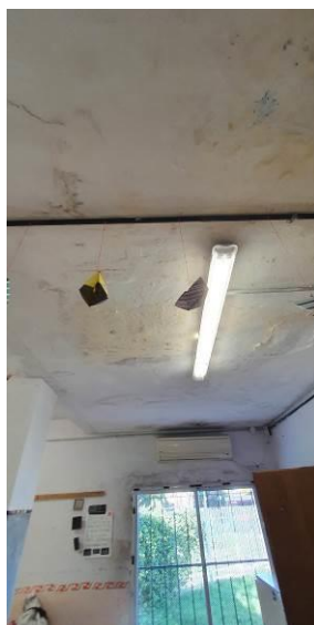
Foto 70 Humedad en pasillo a las aulas. Foto 71 Humedad en aula 1 Foto 72 Humedad en aula 1
