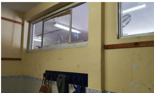
Foto 2 Ventanas de las aulas ventilando al SUM
