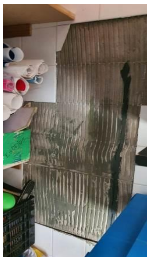
Fotos 63 y 64 Cerámicos sueltos o faltantes en depósito de PB
