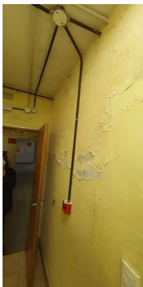
Foto 70 Humedad en pasillo a las aulas. Foto 71 Humedad en aula 1 Foto 72 Humedad en aula 1
