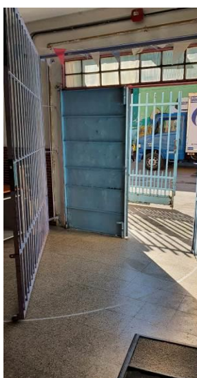
Foto 5 Seguridad: reja + puerta + reja.
