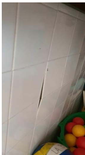
Fotos 63 y 64 Cerámicos sueltos o faltantes en depósito de PB
