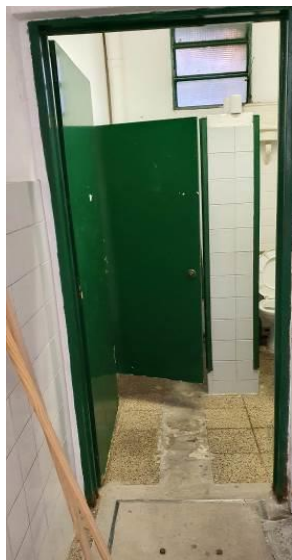
Foto 11 Arreglo cloacal baño H
