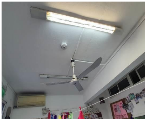
Foto 41 Cerámicos deteriorados Foto 42 Luces sin protección adecuada en aula del frente
