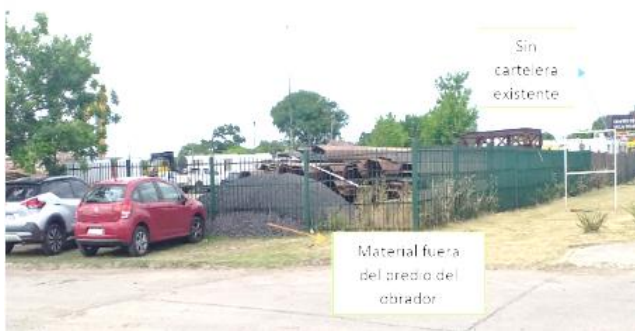
FOTO N° 1 - Esquina del obrador sin cartelera de la empresa no se ven datos visibles para su localización, se observa material estibado fuera del obrador. Los materiales a almacenar se deberían disponer de modo tal de evitar su deslizamiento o caída.
