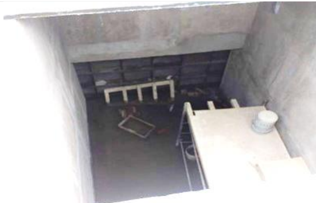
FOTO N° 11 - Dentro del obrador de COARCO S.A., se encuentra la Cámara N.º 5 perteneciente al Ramal Martí. Esta cámara se hallaba abierta lo que permitió identificar sus características y la dimensión y profundidad en que se trabaja.
