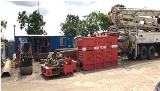
FOTO Nº 5 - Equipos de trabajo sin logos de la empresa, numero ni materiales refractarios para su detección nocturna. De acuerdo a la Ley de Tránsito N° 24.449, su Decreto No. 779/95 y en las leyes correspondientes a cada Jurisdicción, los vehículos y maquinarias de obra que necesiten trabajar y/o circular por vía pública.
