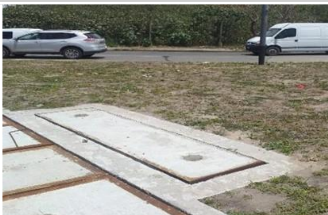
FOTO N° 15 - Cámara N °14 (en ramal Pergamino). Falta reponer vegetación, pintar marcos de hierros oxidados.
