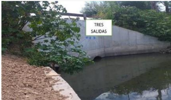
FOTO Nº 17 - Descarga muro de ala y desembocadura de Ramal Pergamino al Río Matanza Riachuelo, (se encuentran semi tapadas).
