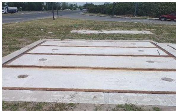
FOTO N° 14 - Esquina Av. Pergamino y Av. 27 de febrero cámara N °14, última cámara de limpieza (Ramal Pergamino) antes de llegar al río Matanza Riachuelo.
