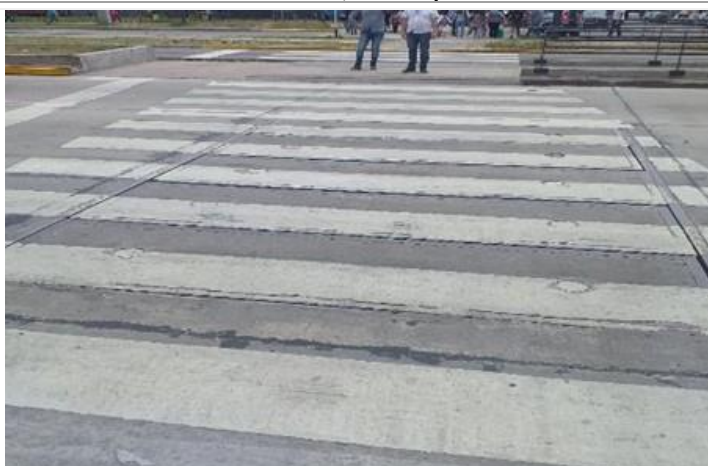
FOTO Nº 21 - Cámara N.º 7 sobre Av. Coronel Roca y Mariano Acosta sobre sendas peatonales hacia estación Metrobús. La pintura de la senda peatonal se observa con deterioró al poco tiempo de ser pintada.
