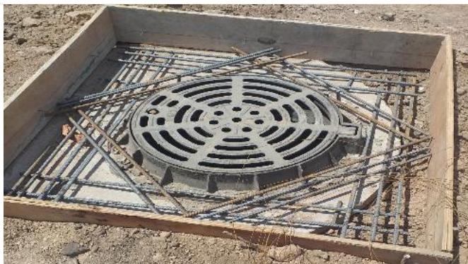
FOTO N° 13 - Preparación para hormigonado de boca de cámara N ° 5 dentro de Obrador, sobre calle Asturias (correspondiente al Ramal Martí).
