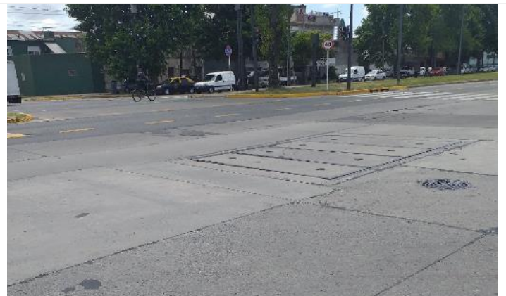
FOTO Nº 20 - Av. Rabanal y Av. Pergamino. Cámara Nº 11
