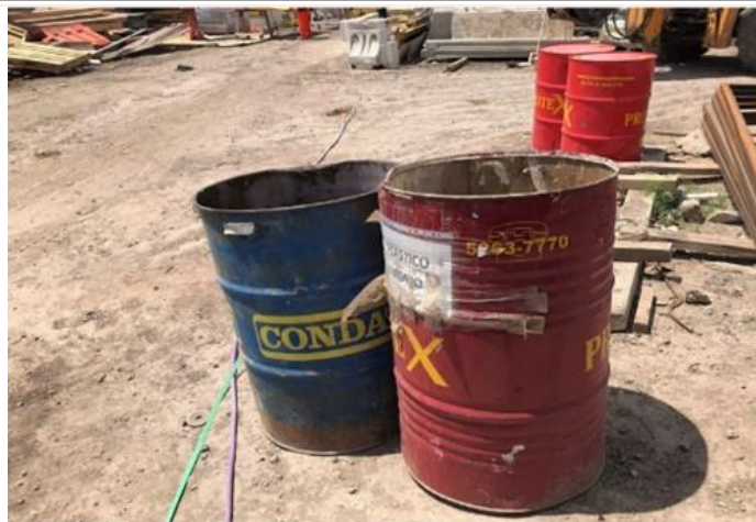
FOTO Nº 10 – Cables eléctricos expuestos (en el piso, sin protección). Lugar de vías de circulación no demarcadas. Falta de orden limpieza, señalética inadecuada. Recipiente de color rojo (inadecuado, según Plan integral de identificación, separación y disposición de residuos 42 ). “Se dispondrán estaciones ambientales tanto en el obrador como en los distintos frentes de trabajo. Las mismas dispondrán de cuatro recipientes, uno de color negro para RSU, otro de color azul para las latas vacías de grasas, pintura y selladores, un tercero de color verde para materiales reciclables y un cuarto de color amarillo para materiales de origen COVID 19”
