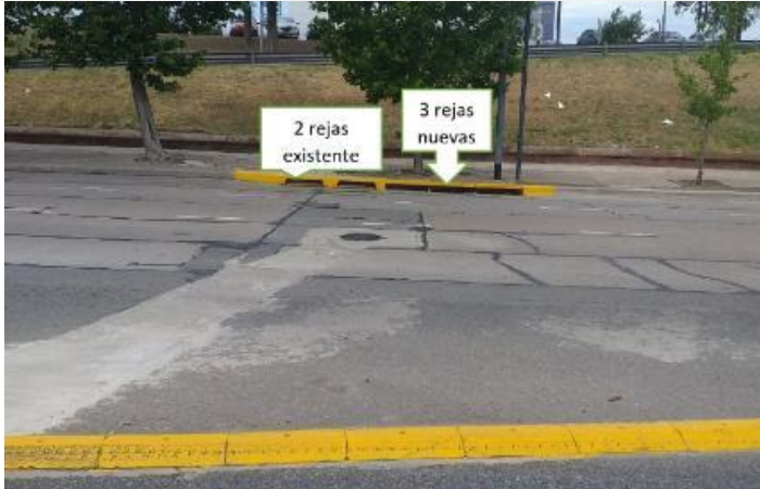
FOTO Nº 23 - Sumideros nuevos de tres rejillas y viejos existentes de 2 rejillas Av. Coronel Roca
