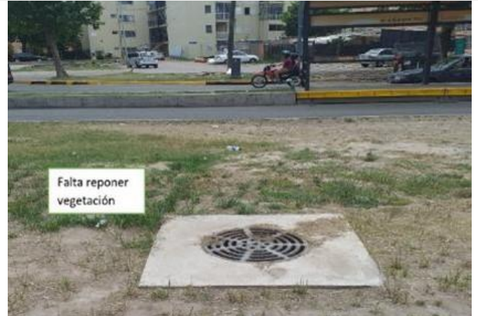
FOTO Nº 24 - Cámara N.º 6 Av. Coronel Roca y Av. Lacarra, ubicada sobre bulevar. Falta reposición de vegetación
