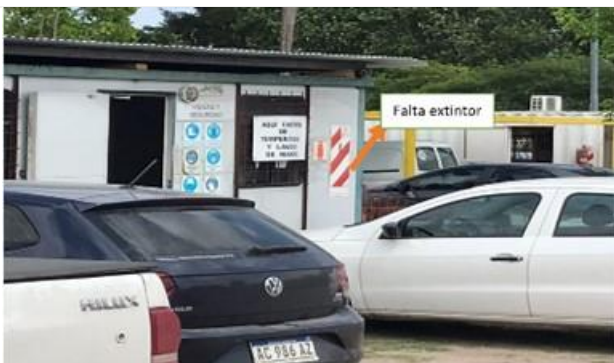
FOTO Nº 7 - Oficina de Higiene y Seguridad. Falta instalar extintor. El control de COVID-19 se realiza en oficina de H y S, cuando debería ser al ingreso del establecimiento (obrador).
