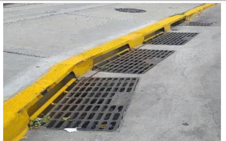
FOTO Nº 22 - Sumideros nuevos de tres rejas, uno pre-existente.
