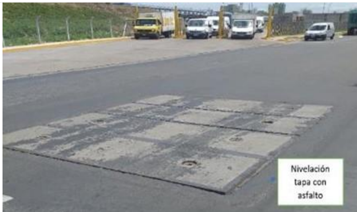
FOTO Nº 19 - Cámara N.º 12 sobre Av. Pergamino y Julio Troxler (salida CTC). Cámara de ingreso para limpieza y mantenimiento. Tapas elevadas sin juntas perimetrales de dilatación. Falta de demarcación vial, sendas peatonales.
