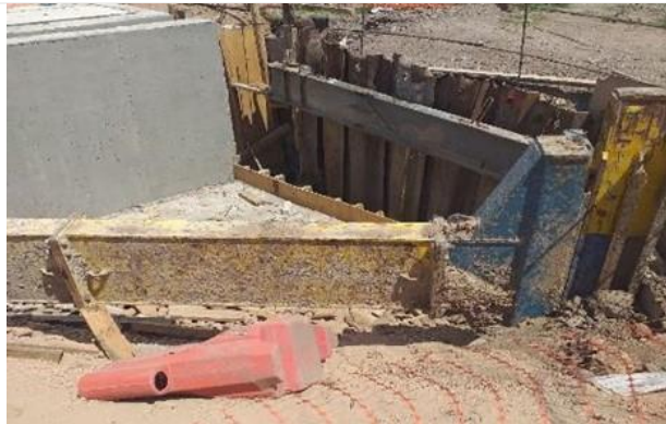
FOTO N° 12 - Construcción de compuerta de la cámara N°5 realizada a cielo abierto dentro del predio del obrador. Es obligatoria la identificación y señalización de todos los lugares que en obra presentan riesgo de caída de personas y la instalación de adecuadas protecciones. Éstas no se hallaron.
