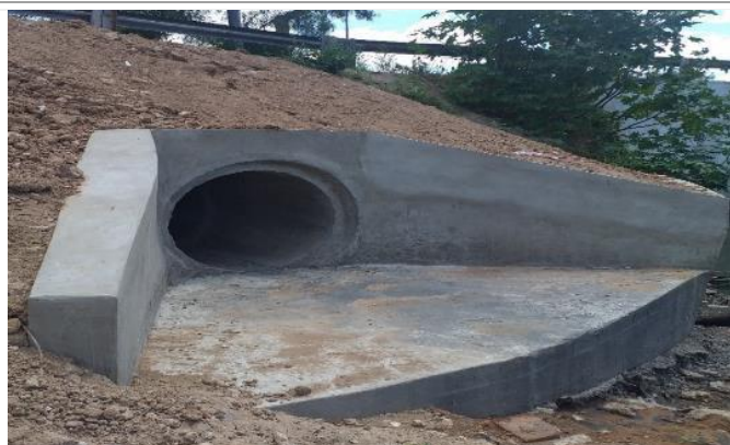
FOTO N° 16 – Salida (hacia Riachuelo) de los sumideros de la zona , falta de relleno y vegetación
