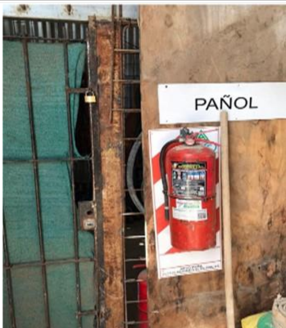
FOTO Nº 9 - Falta de pintura y limpieza (oxido y suciedad en paredes de material tipo fenólico).
