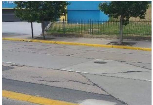
FOTO Nº 26 - CÁMARA Nº10 Av. Coronel Roca frente entrada Centro de Transferencia de Carga, giro y empalme de cañerías.
