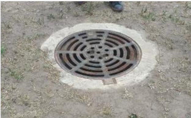
FOTO Nº 25 - Cámara contractiva N.º 9 Av. Coronel Roca (sobre Boulevard). Falta de pintura y vegetación
